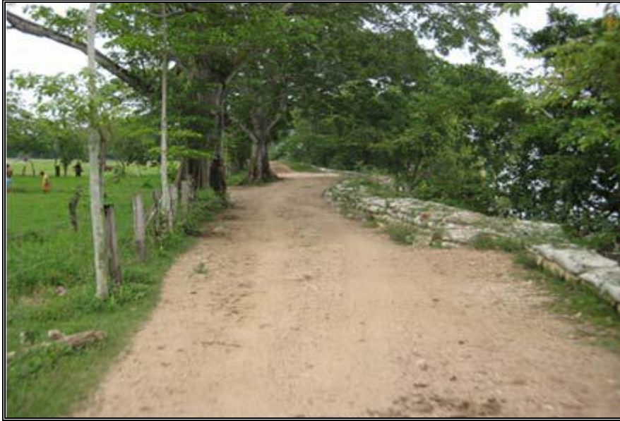
Figura 4: Tramo bajo de dique. En algunos tramos se hizo necesaria la colocación de bolsa suelos para impedir el desborde del brazo de Loba.
