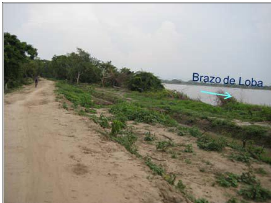
Figura 3: Dique vía existente El dique-vía no cuenta con una conformación adecuada, fue utilizado préstamo lateral para su construcción.
