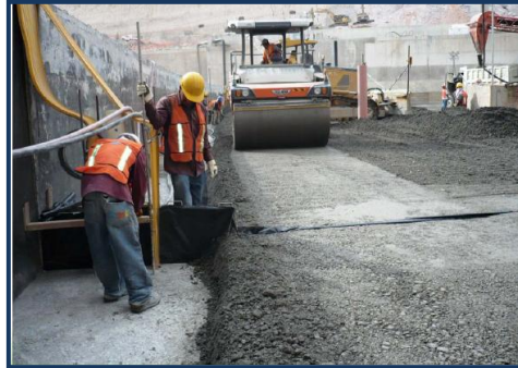
Figura 6. Aplicación de CCR en presas. Fuente: (Orellana & Carrillo Vasquez, 2003).
