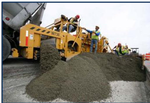
Figura 5. Descargue de CCR de camión de volteo
