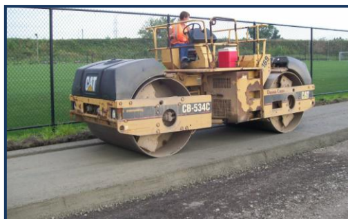
Figura 15. Compactación de CCR mediante Compactador de Rodillo.
