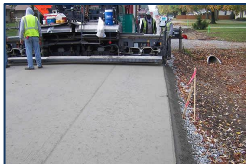
Figura 12. Extendedora Convencional de alta densidad en compactación de CCR en Pavimentos Fuente: (Calumet Civil Contractors, Inc., 2014)
