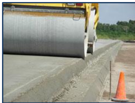
Figura 1. Compactación de CCR en Pavimentos. Fuente: (The Concrete Promotional Group, Inc., 2014)
