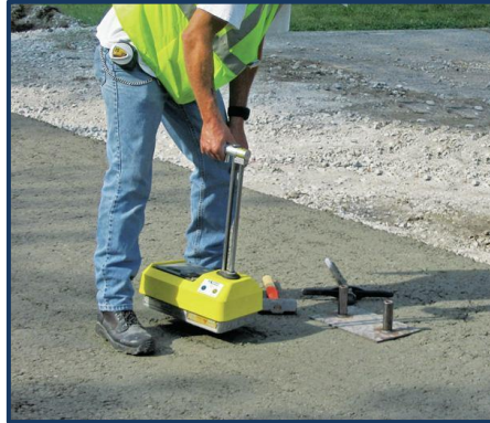
Figura 16. Toma de densidad mediante densímetro Nuclear. Fuente: (Concrete Construction, 2014)
