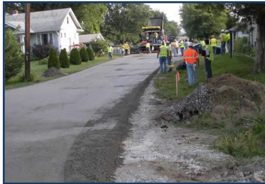
Figura 17. Pavimento en CCR
