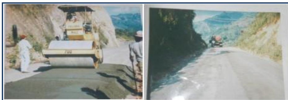
Figura 13. Construcción de tramo experimental vía de acceso a la fábrica de cementos diamante. Fuente: (Bonilla Rodriguez & García Pinto, 2009)
