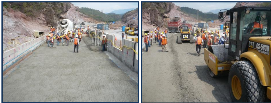
Figura 7. Aplicación de CCR en construcción de presas.
