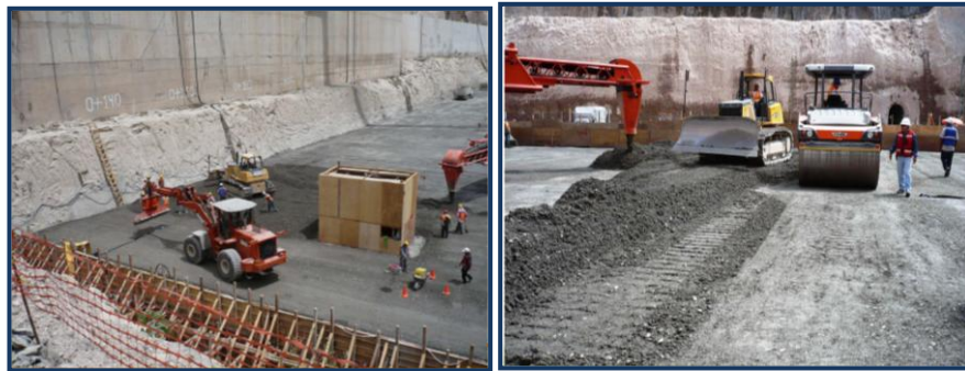
Figura 8. Aplicación de CCR en construcción de presas.
