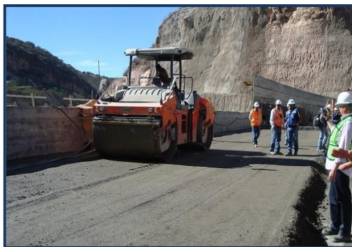
Figura 4. Compactación CCR con Rodillo Vibratorio. Presa Zapotillo. Jalisco, México. Fuente: (Ramirez Reynaga, 2012).
