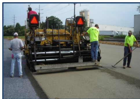
Figura 3. Aplicación de CCR en Pavimentos. Fuente: (Specify Concrete, 2014)
