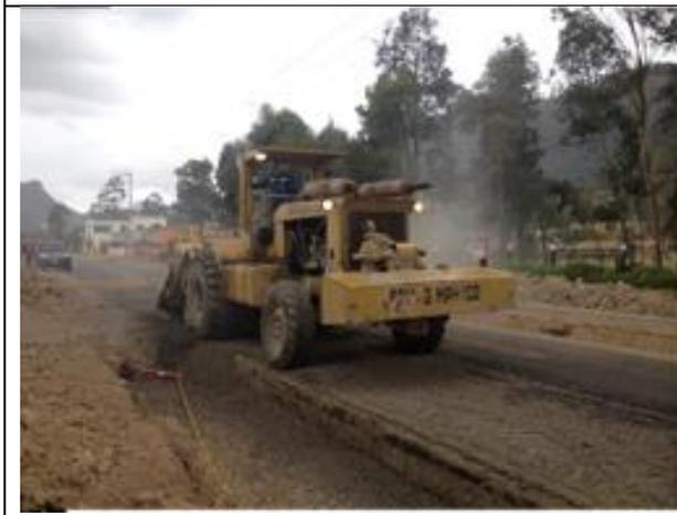
Reciclado con base estabilizada con emulsión asfáltica y cemento tipo BEE-1 k0+150 a k0+650.
