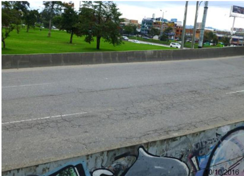
*Ilustración 8 Estado Actual del Puente de Calle 170 con Autopista norte (Sentido Occidente - Oriente) Grieta de reflexión de juntas*
