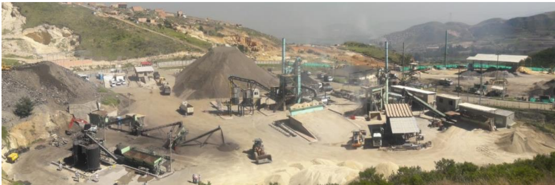
Ilustración 4 Predio La Esmeralda- UAERMV, Fuente: http://www.umv.gov.co/portal/nuestros-servicios/#1489846767062-e9fe3622-d548
