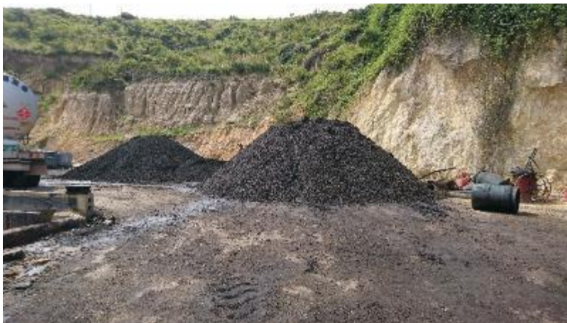
Ilustración 5 Lugar de acopio del material RAP en la planta predio La Esmeralda Fuente: Informe TP Fresado Estabilizado del 24 de enero de 2018 - UMV.
