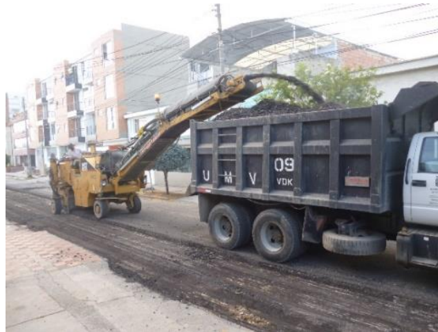
Ilustración 1 Fresado de una vía en la localidad de Barrios Unidos – Fuente propia
