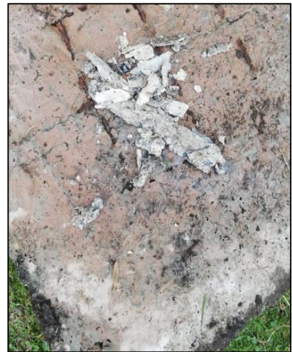
Ilustración 11. Grasa en bloques tubería restaurante.
