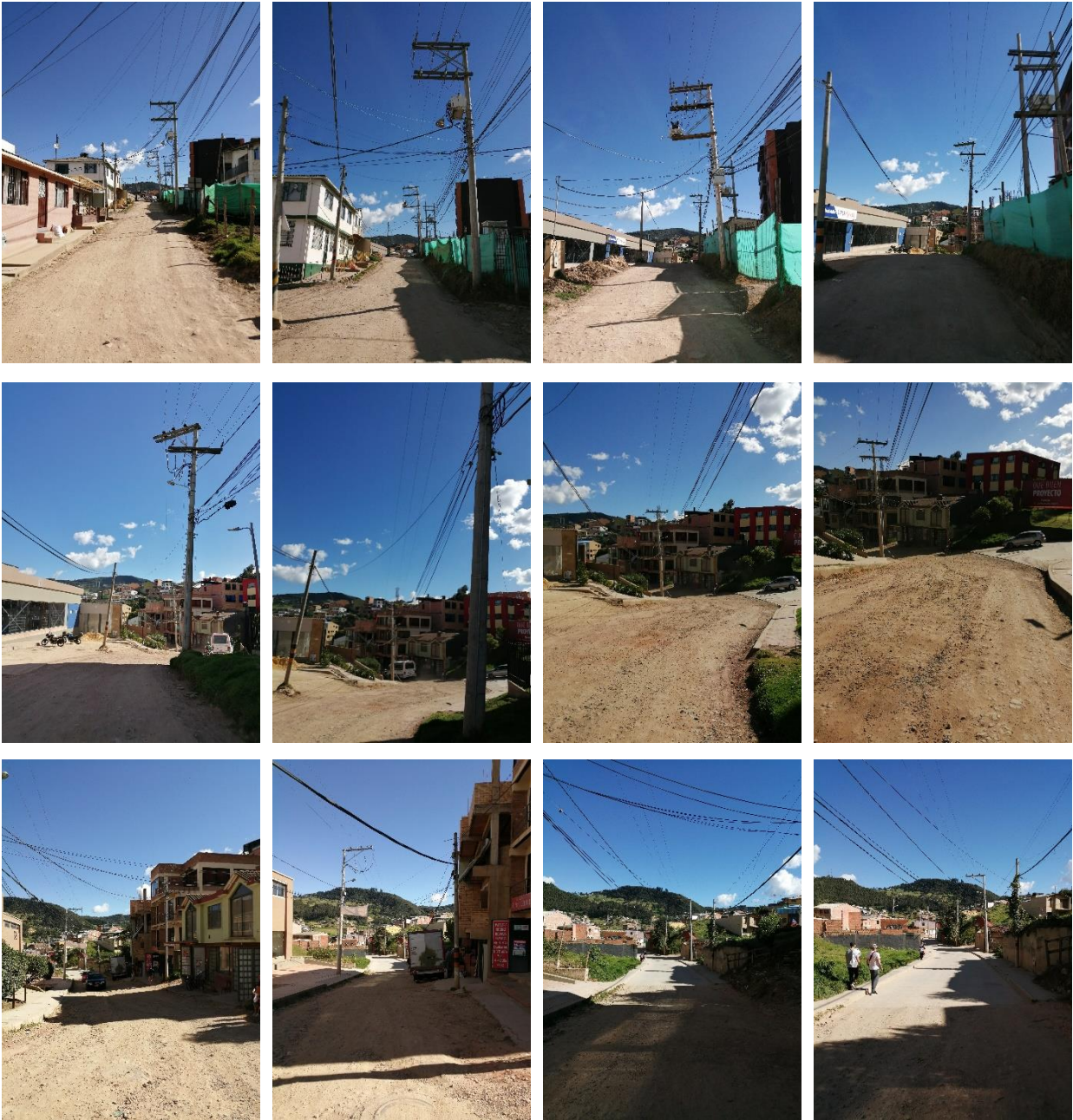
Ilustración 7 Estado actual del tramo a intervenir (Leonardo Fonseca, 2021)
