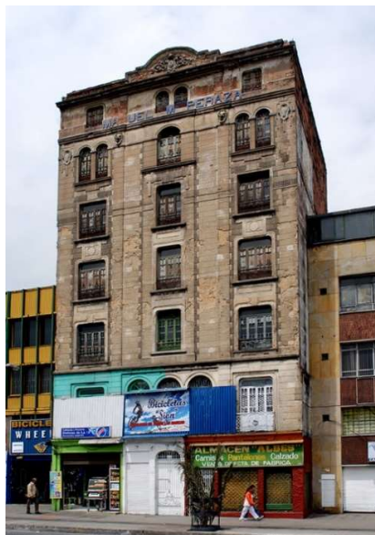
Ilustración 2. Edificio Manuel M. Peraza.
