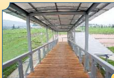
Rampa de acceso
