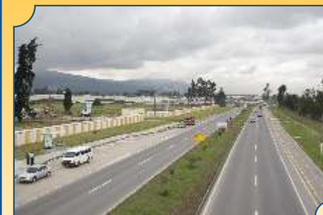
Muro de cerramiento Carril de desaceleración
