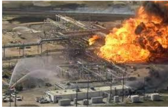
Figura 1. Accidente en Planta de British Petroleum Company, Texas USA. Marzo, 2005
