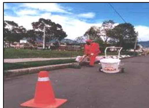
Figura 3. Barrido y Limpieza.
