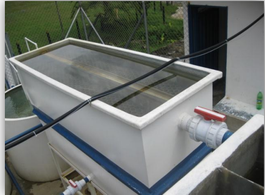
Figura No 4. Sedimentador típico y/o estándar, PTAP de El Peñol - Antioquia.
