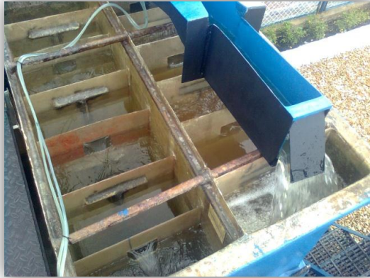
Figura No 3. Floculador de flujo horizontal PTAP municipio de Ráquira – Boyacá.
