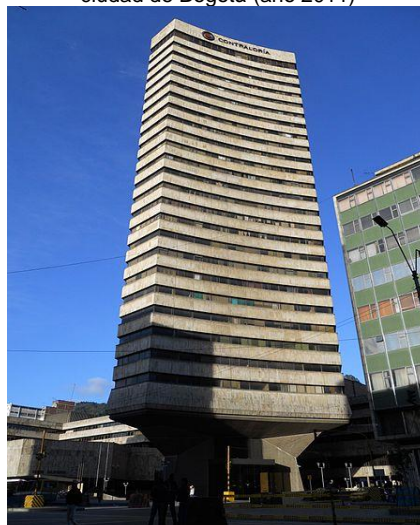
Imagen 2: Edificio antiguo de la sede central donde funcionaba la sede central de la Contraloría General de la Republica en la ciudad de Bogotá (año 2011)
