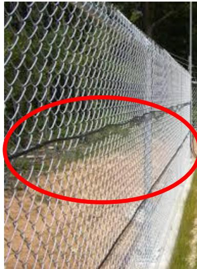
*FIGURA 3.* Cables Microfónicos.
