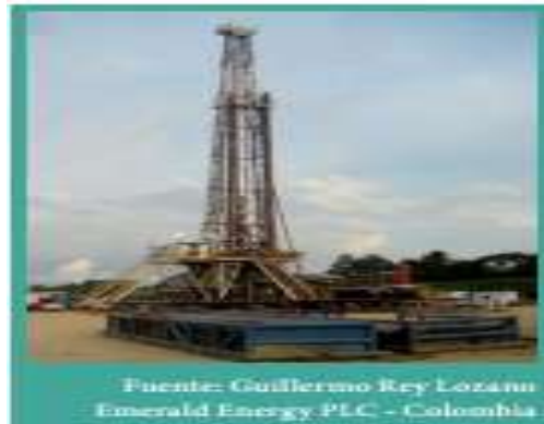
Figura No. 1 Hidrocarburos
