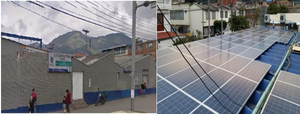
Figura 3. Montaje de Paneles solares Sede Administrativa
