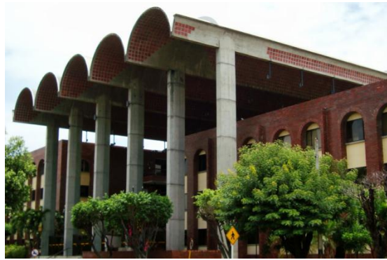
Imagen 23. Cubierta en Membrana Circular. Palacio de Justicia de Cúcuta.
