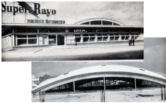
Imagen 19. Membrana de doble curvatura, Supermercado Rayo (Bogotá, 1955). Fuente: Guillermo González Zuleta & CIA
