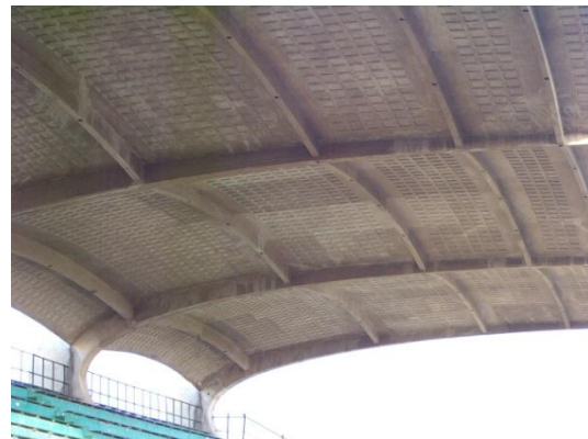
Imagen 13. Membrana en Concreto, Cubierta del Estadio de Beisbol Mariano Ospina.
