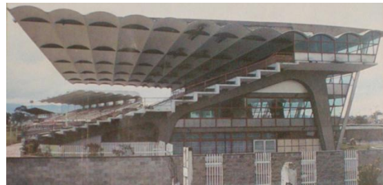
Imagen 19. Cubierta en Membrana Circular. Hipódromo de Techo. Fuente: Guillermo González Zuleta & CIA
