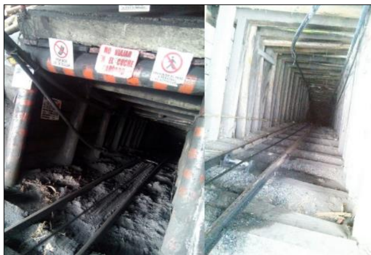
Figura 1. Mina de carbón típica de la zona. Fuente propia.
