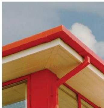
Imagen N°3 Tipos de canaletas para recolección de agua lluvia
