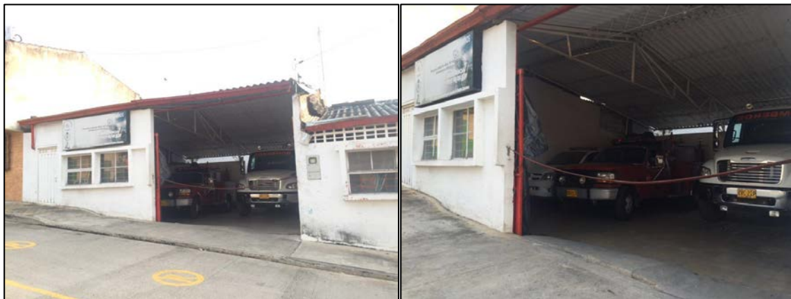
Figura 7. Estación de bomberos
