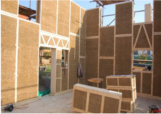
Figura 4: Sistema constructivo con paneles de paja prefabricados
