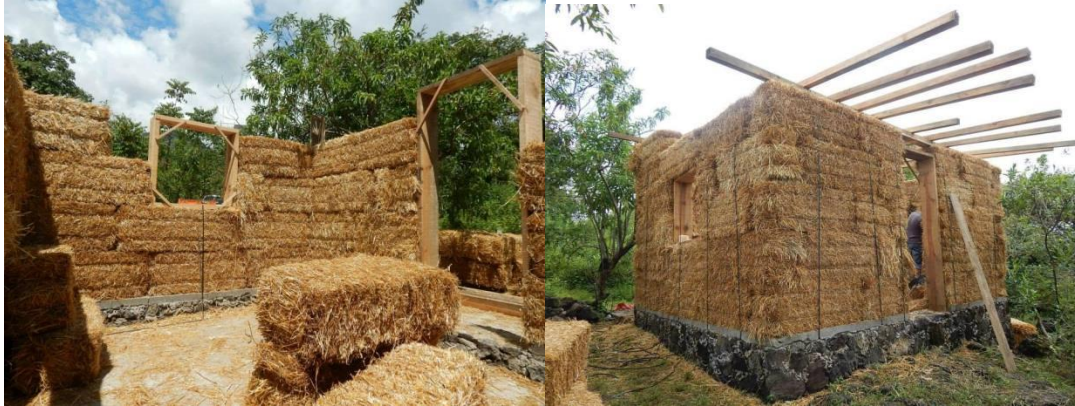
Figura 2: Sistema constructivo Nebraska Fuente: Construpaja Argentina, 2015 [11]
