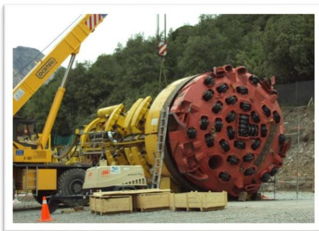
*Figura 4 Montaje de Tuneladora (TBM) Proyecto Hidroeléctrico Chacayes*
