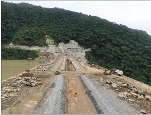
Fotografía 1. Infraestructura del proyecto Hidroeléctrico Pescadero – Ituango. Fuente: Elaboración propia.
