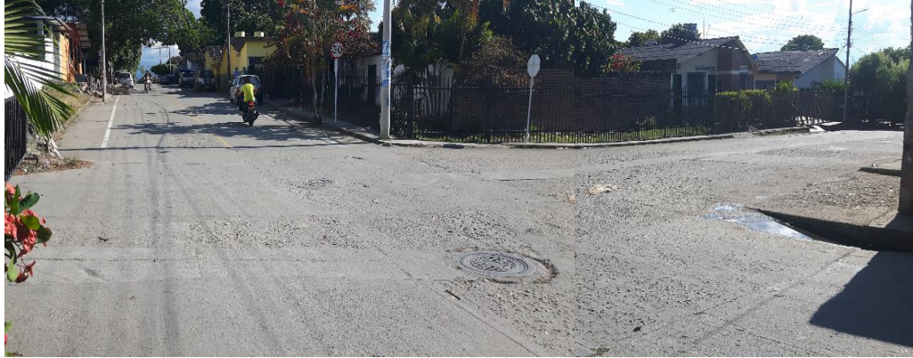
Figura 19: Registro Fotográfico Calle 2 –Carrera 7- Fuente propia
