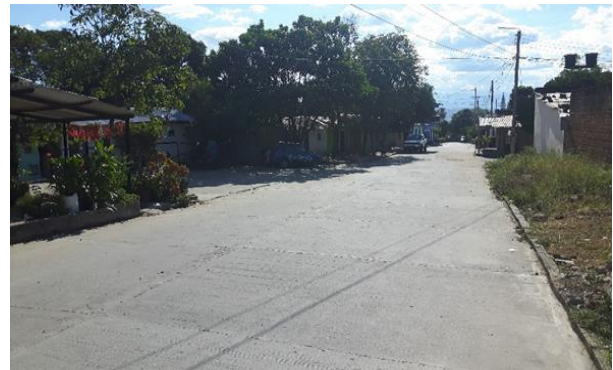
Figura 14: Registro Fotográfico Calle 1 –Carrera 9- Fuente propia
