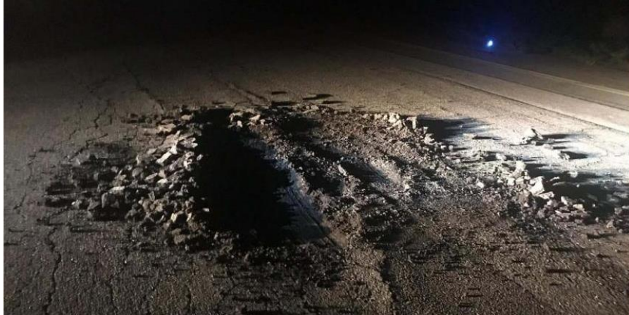
Ilustración 3. Huevo en pista aeropuerto de Valledupar
