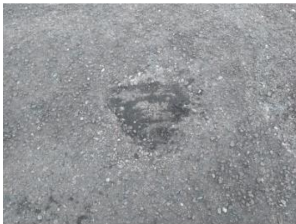
Ilustración 6. Baches en pista (Aeropuerto florencia)
