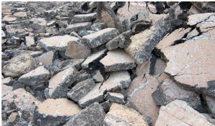
Ilustración 4. Escombros de la demolición de asfalto de la carretera
