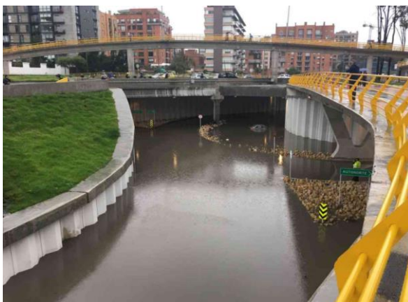
Figura 2. Inundación Interconector de la calle 94
