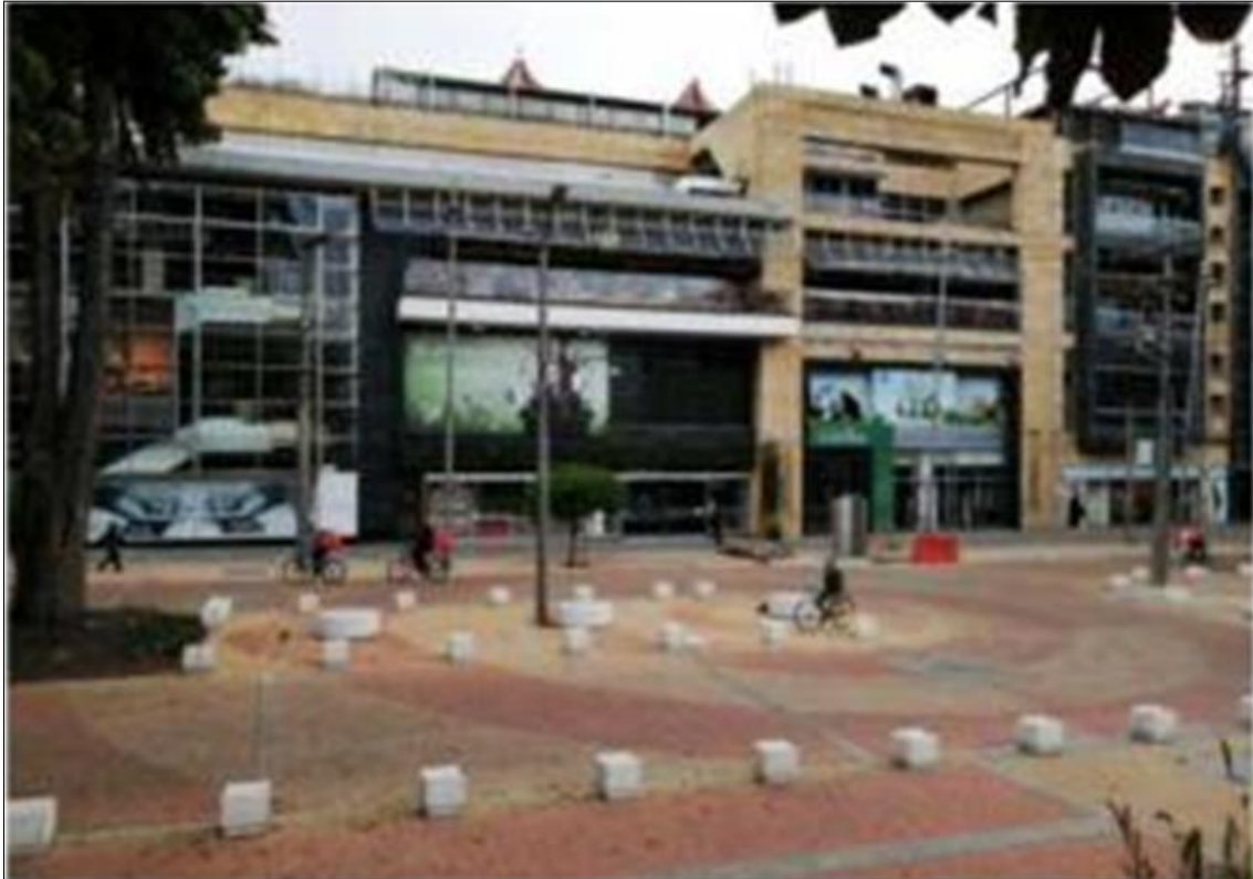
Figura No. 14 Sector de la zona T en proceso de mejoramiento arquitectónico
