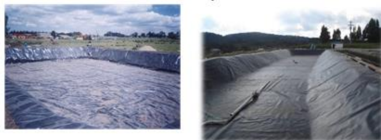
Figura 5 Impermeabilización del terreno; Fuente:(BIOLODOS & León, 2020)
