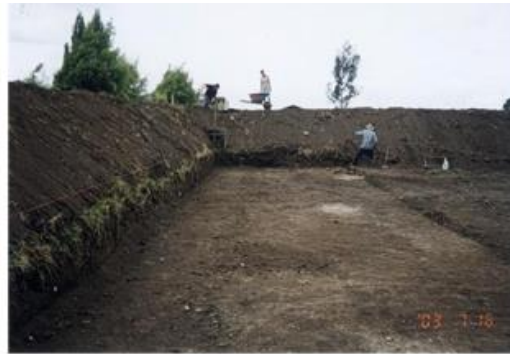
Figura 4 Adecuación del terreno; Fuente:(BIOLODOS & León, 2020)
