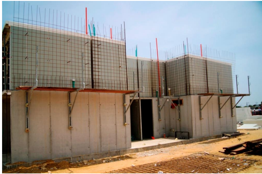
Figura 6. Concreto industrializado en construcción de vivienda.
