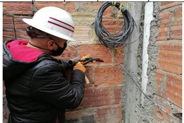
Fotografía 9 Bloque deteriorado con pérdida de material .
