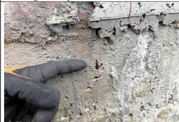
Fotografía 8 Aceros de columna expuestos en muro externo.
