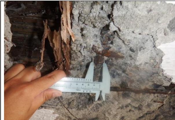
Fotografía 6 Exploración estructural en columna
