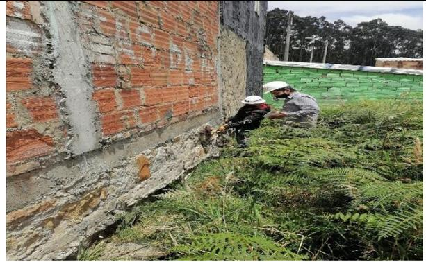
Fotografía 23 verificación de vigas cimentación
