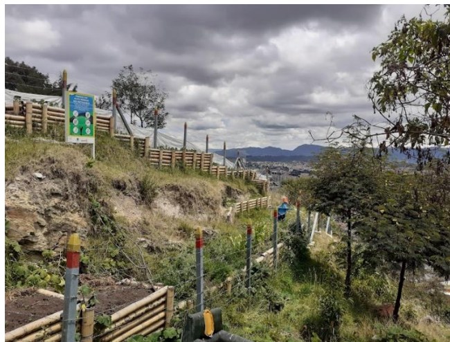
Figura 2. Estabilización de taludes con bioingeniería.
