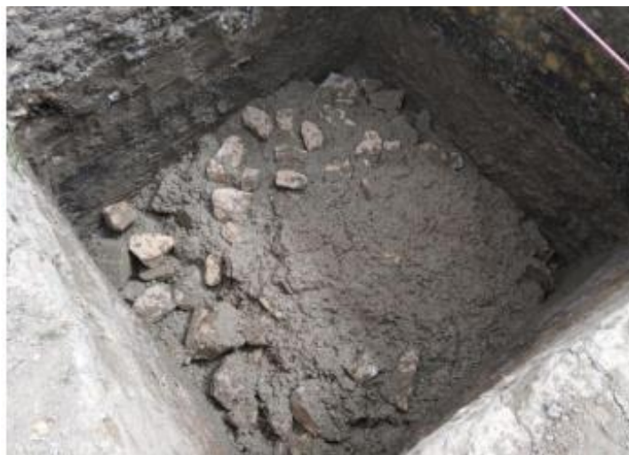
Figura 6. Soporte concreto ciclópeo para cimentación
