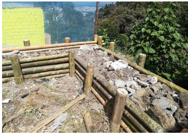
Figura 1. Relleno de estructura de bioingeniería con hormigón reciclado
