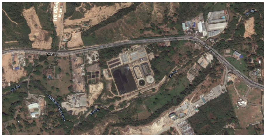
Figura N° 1. PTAR Río Frío.
