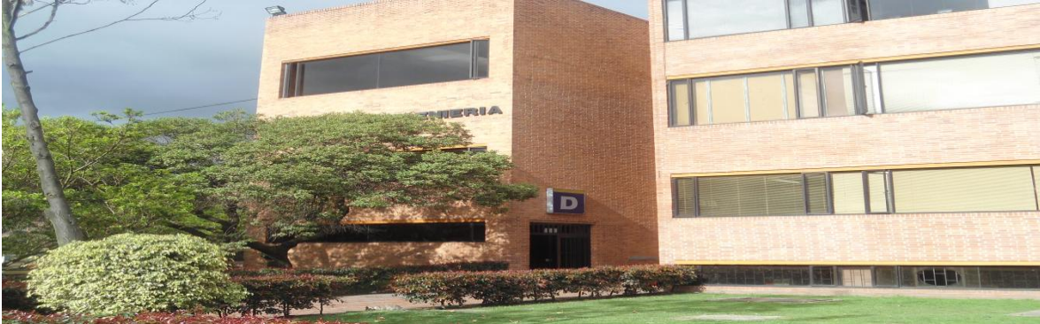
Fotografía 3 Bloque D Facultad de Ingeniería.
