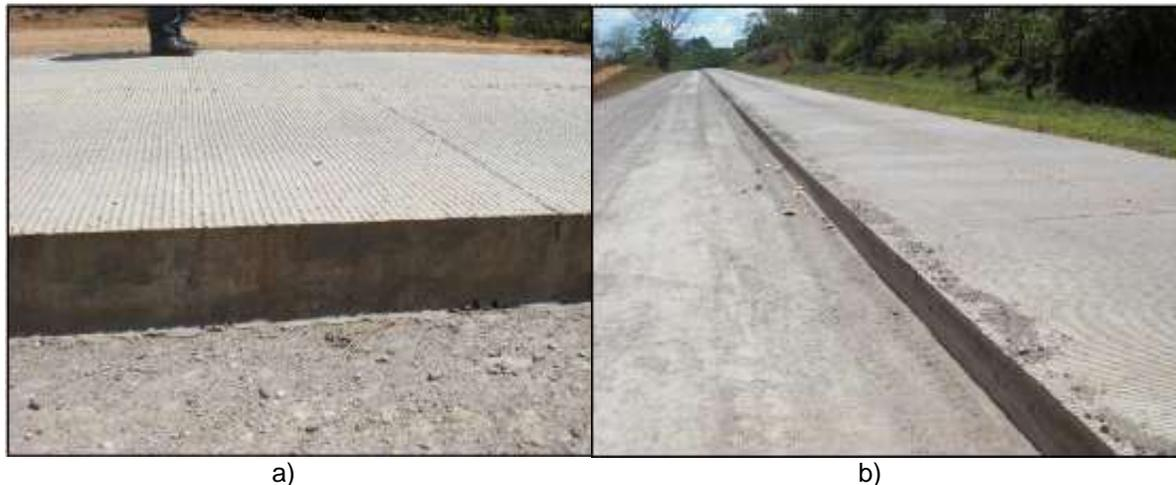
**Fotografía 12.** Año 2009. a) Fisuras superficiales b) Carril derecho de la vía.
