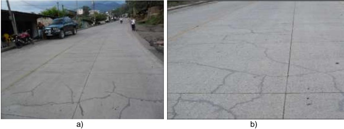
**Figura 15.** Año 2013. a) Estado de la vía a 2013 b) Sello de fisuras en la vía.
