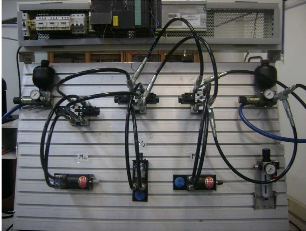
Fig. 6.6. Montaje hidráulico del sistema implementado
