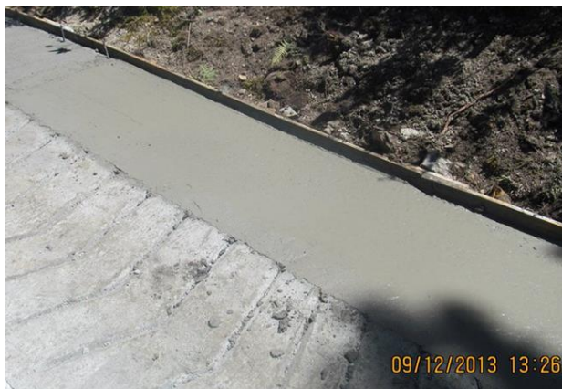
Figura 8. Construcción cunetas.
