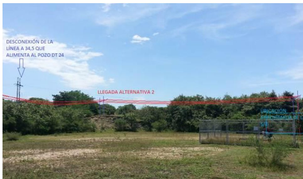
Imagen 48 Llegada a la estructura terminal PÍA - DT 70 (Quitando la red de 34,5 kV existente)
