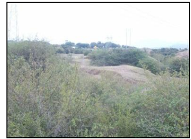
Imagen 14 Vista posterior del grupo de viviendas ubicadas cerca a la Subestación Tenay
