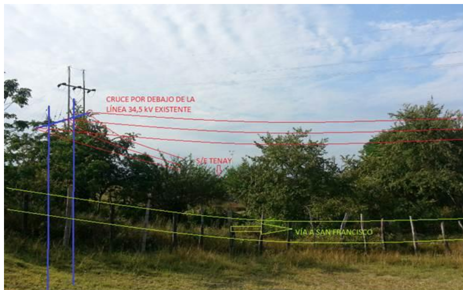
Imagen 44 Cruce de la línea 34,5 kV con la vía a San Francisco y cruce con la línea 34,5 kV existente
