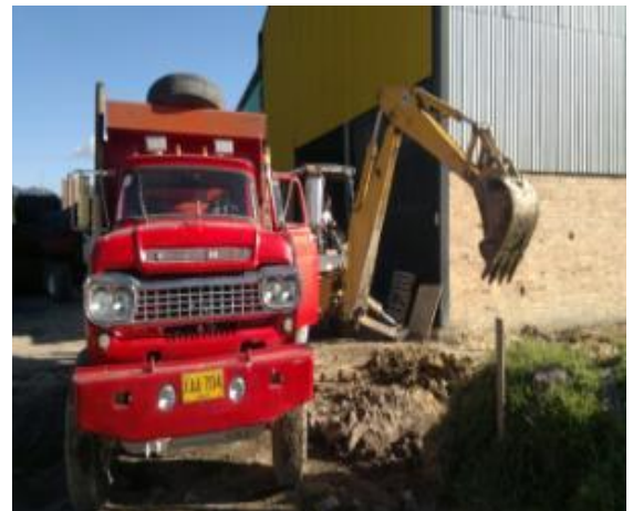
Retiro de escombros y material sobrante.
