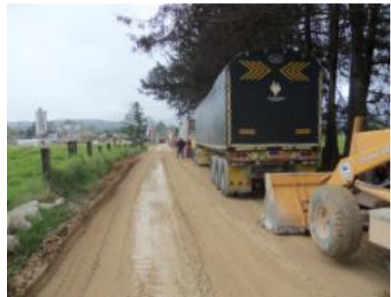
Tracto mulas en el corredor intervenido lo cual dificulta las labores de extendido y compactación del material, teniendo en cuenta el espacio reducido para maniobrar con las maquinas.
