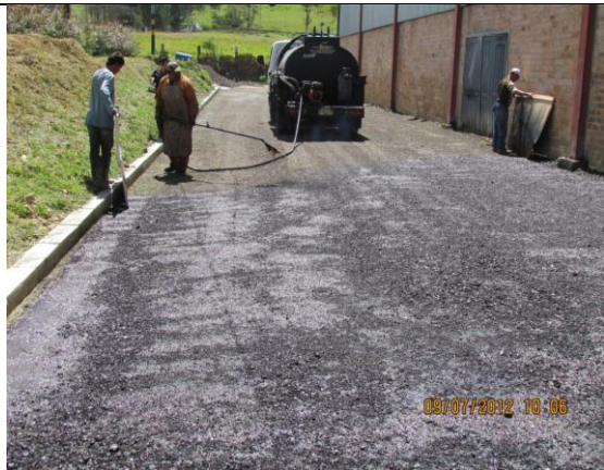
Suministro y aplicación de emulsión asfáltica
