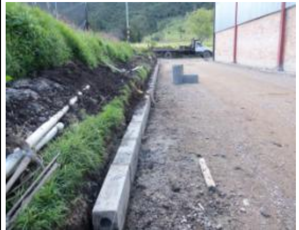
Instalación de elementos para confinamiento
