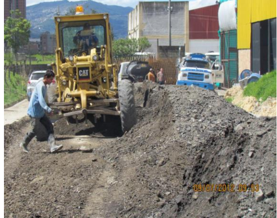
Extendido del material
