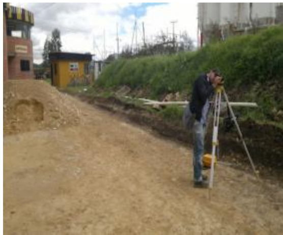
Nivelación del tramo construido para garantizar buenas condiciones de drenaje
