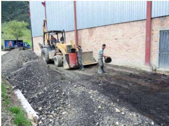
Transporte y disposición del RAP, se debe descargar en forma de cordón.
