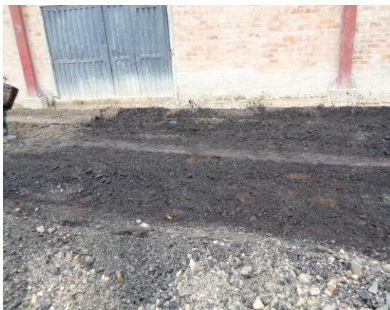
Imprimación con emulsión asfáltica
