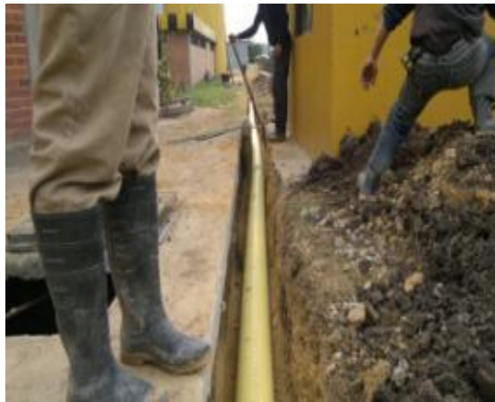
Instalación de tubería de 8" pulgadas Novafort para drenar las aguas lluvias que llegan al tramo a construirse.
