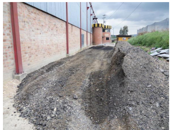
Extendido del material para aplicar nueva capa de emulsión y lograr una mezcla homogénea
