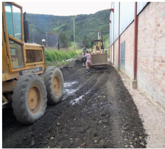
Extendido y chequeo del material para ver si es necesario aplicarle más emulsión
