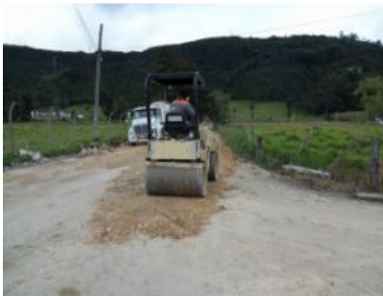
Instalación de Sub-base tipo B-200
