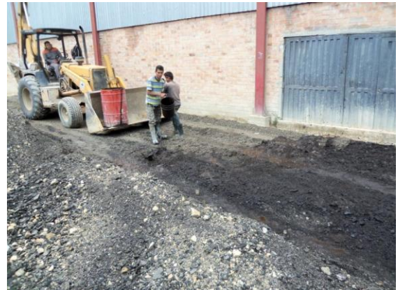
El material se debe humedecer para mejorar sus condiciones de aleación con la emulsión asfáltica
