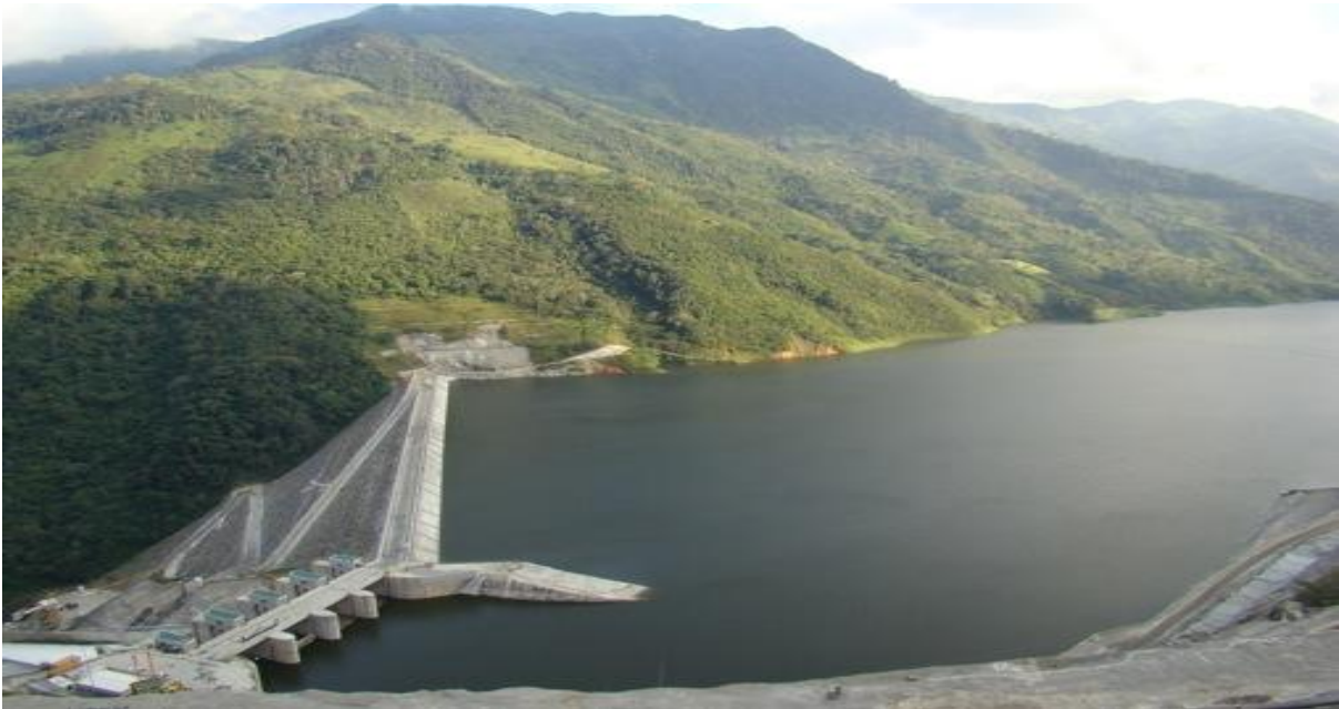
Foto 4 COMPLEJO HIDROELÉCTRICO PORCE III
