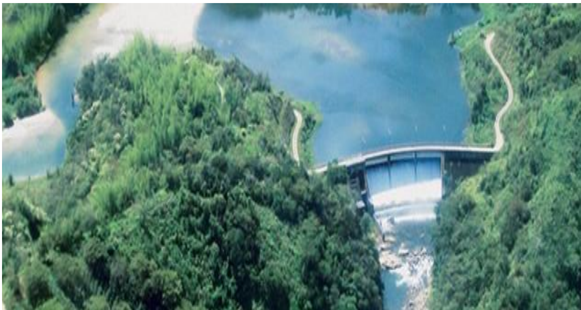
Foto 17 REPRESA DEL RIO CALDERAS
