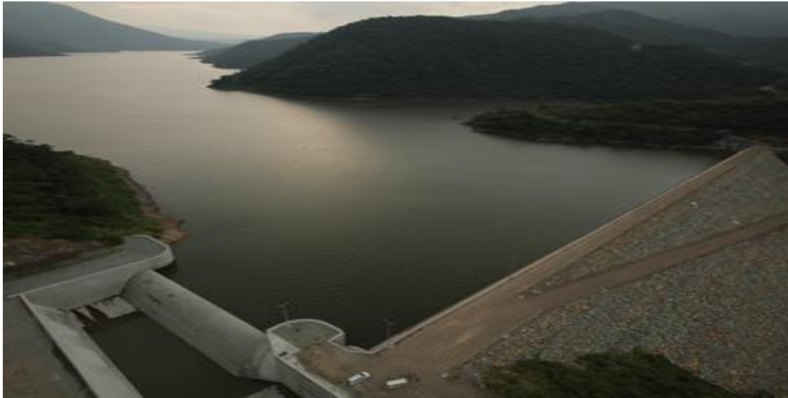
Foto 30 ESTRUCTURA DE CONTENCIÓN PARA GENERAR EMBALSE DEL RIO RANCHERÍA
