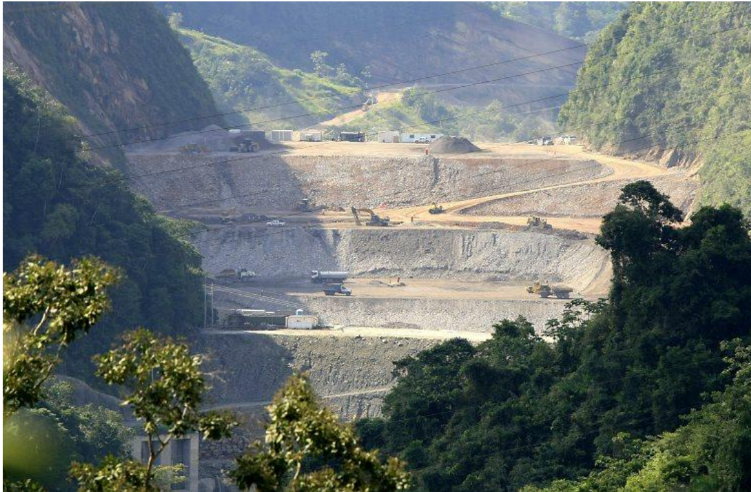
Foto 20 OBRAS ADELANTADAS PARA LA REPRESA DEL RIO SOGAMOSO
