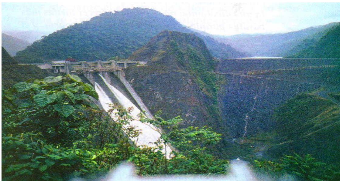
Foto 7 REPRESA ANCHICAYÁ Fuente: Corporación Autónoma Regional del Valle
