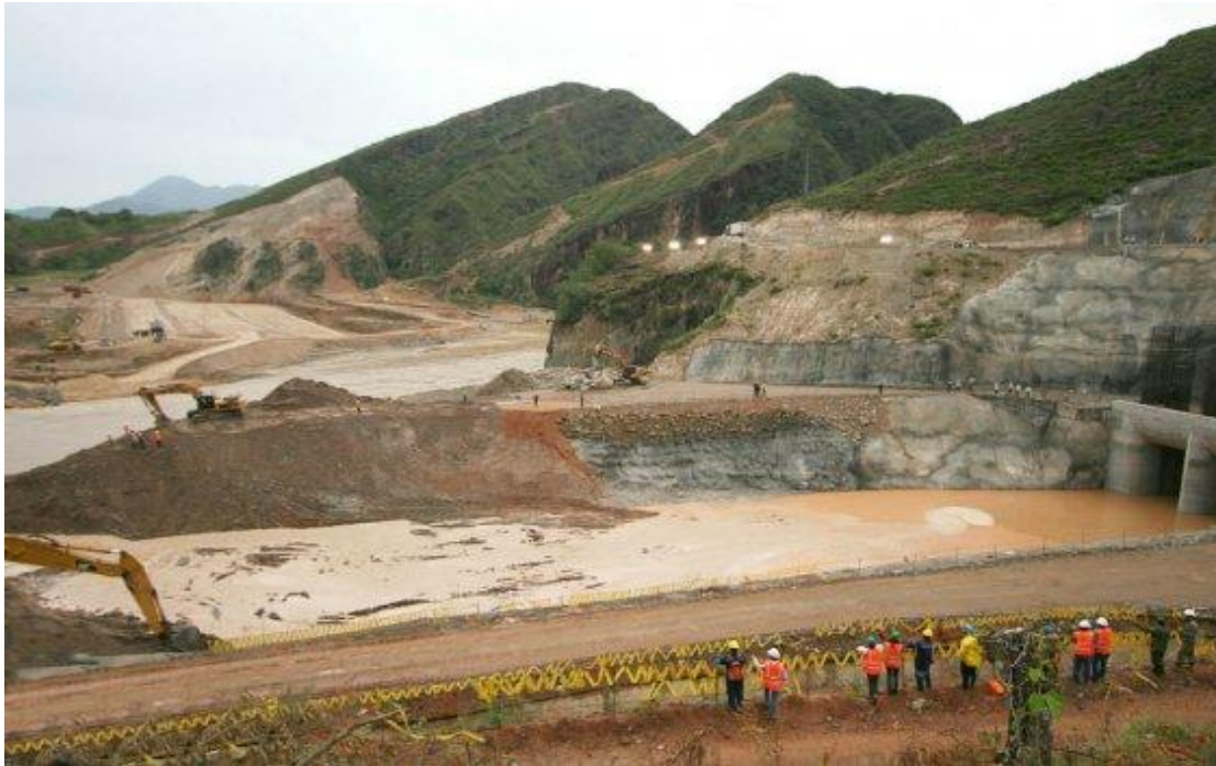
Foto 21 OBRAS PARA REPRESAMIENTO DEL RIO MAGDALENA – PROYECTO HIDROELÉCTRICO DEL QUIMBO
