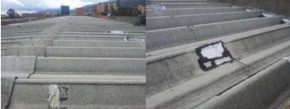
Ilustración 17 Techo detalle – Edificio E
