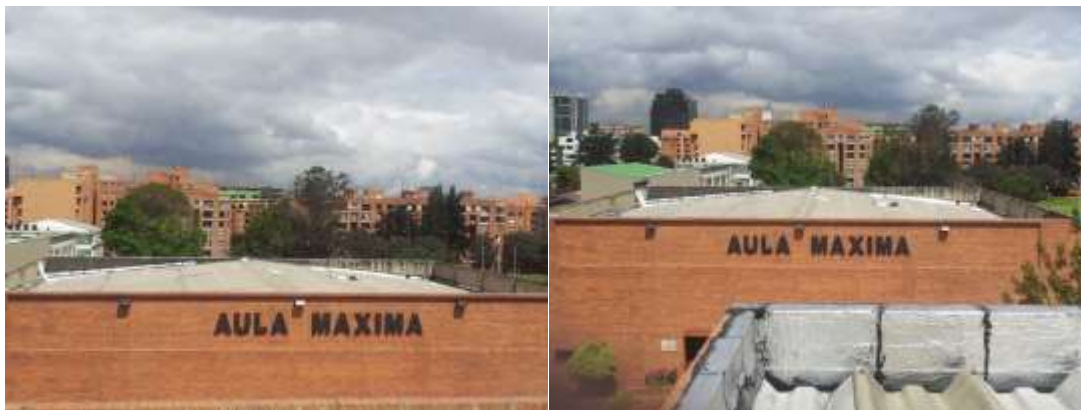
Ilustración 29 Cubierta Aula Máxima
