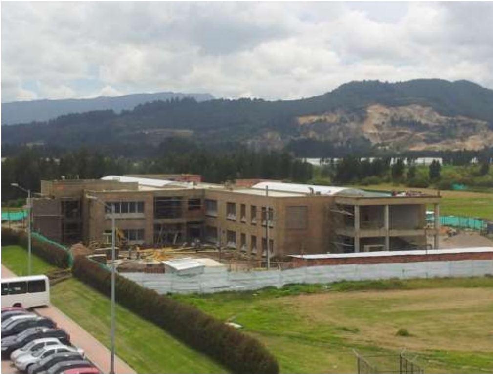
Ilustración 36 Construcción de nuevos edificios
