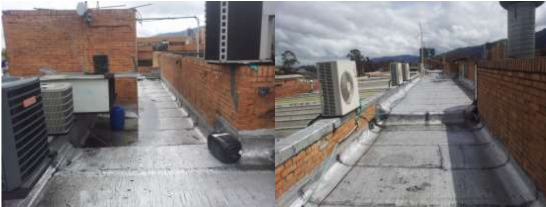
Ilustración 19 Ingreso a los techos
