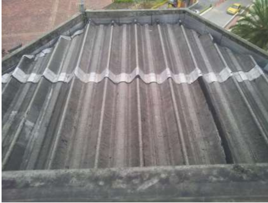
Ilustración 50 Cubierta de salones del primer piso
