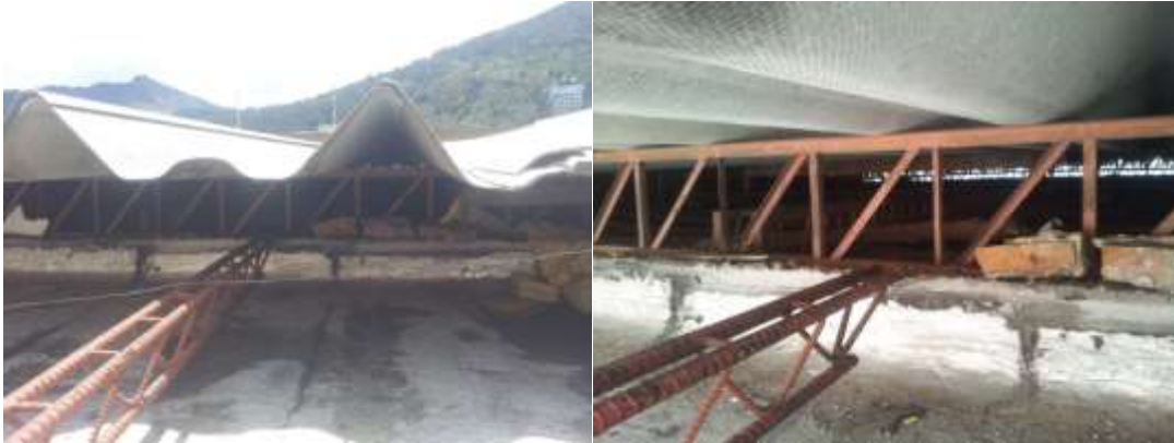
Ilustración 27 Estructura Techo Administración
