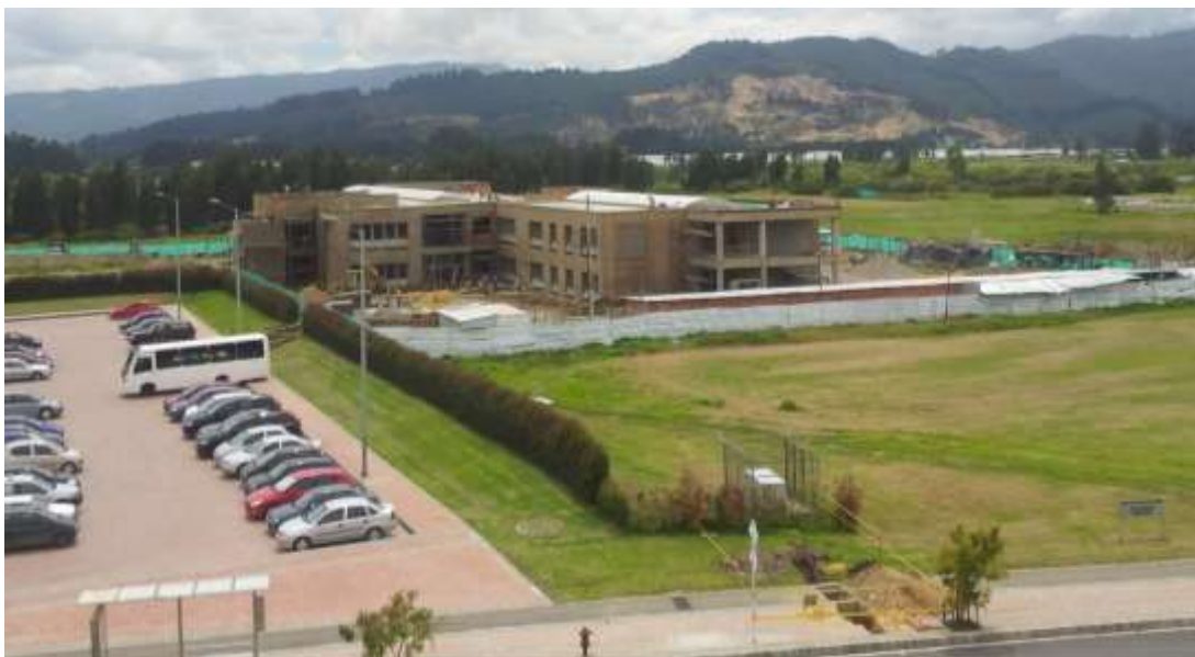
Ilustración 35 Construcción de nuevos edificios
