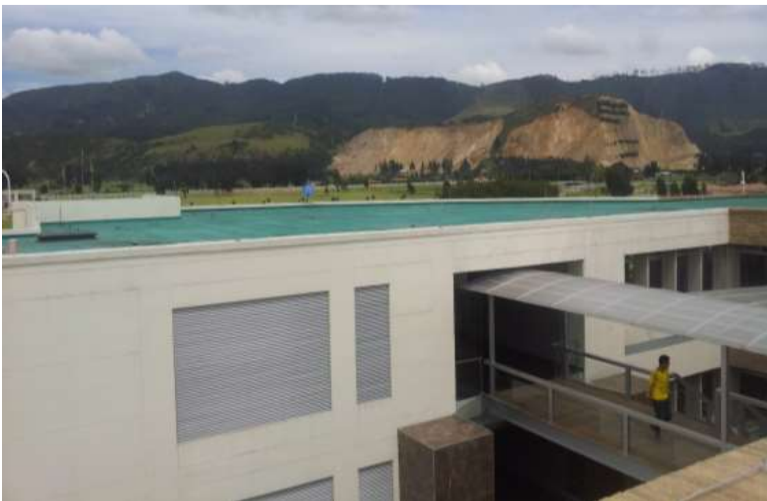
Ilustración 37 Conexión entre edificios con vista a techos.
