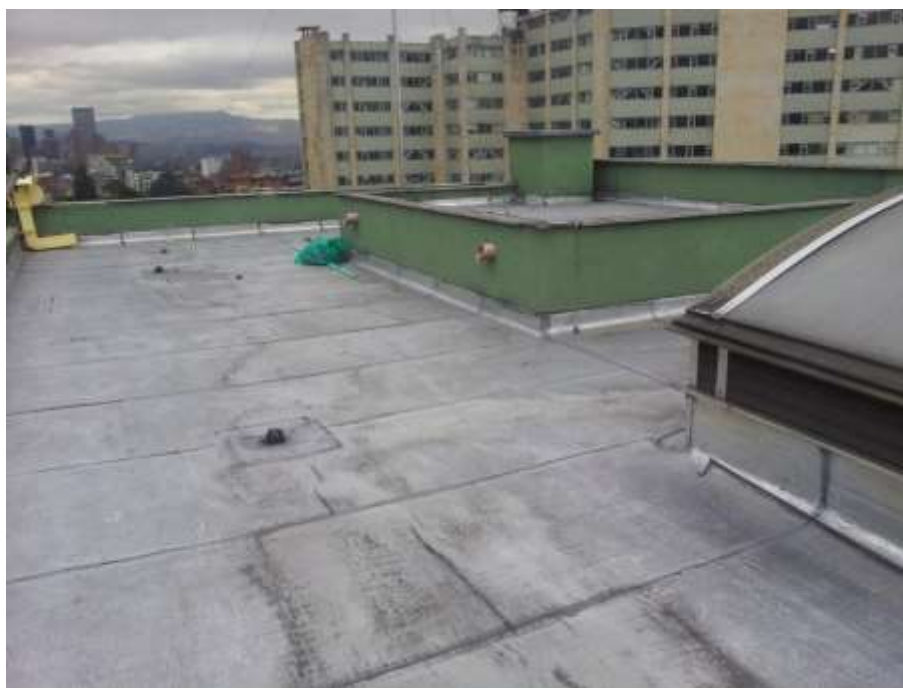
Ilustración 58 Cubierta - Edificio Germán Díaz Díaz - II
