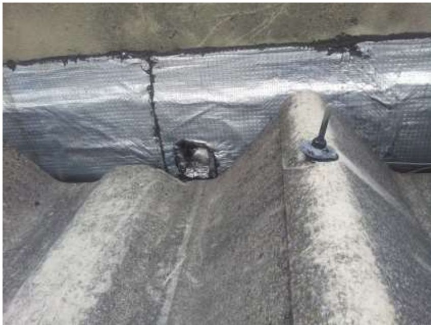
Ilustración 53 Detalle de viga canal - II
