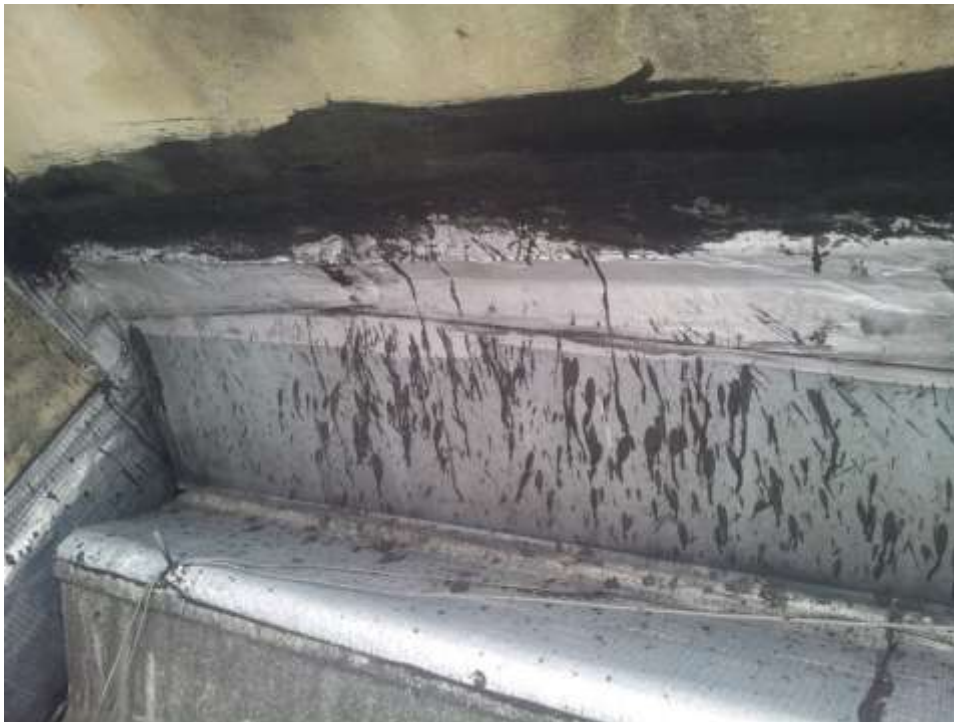
Ilustración 51 Detalle de manto en cubierta
