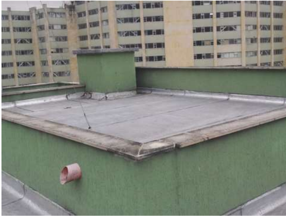
Ilustración 60 Detalle en cubierta - Edificio Germán Díaz Díaz - II
