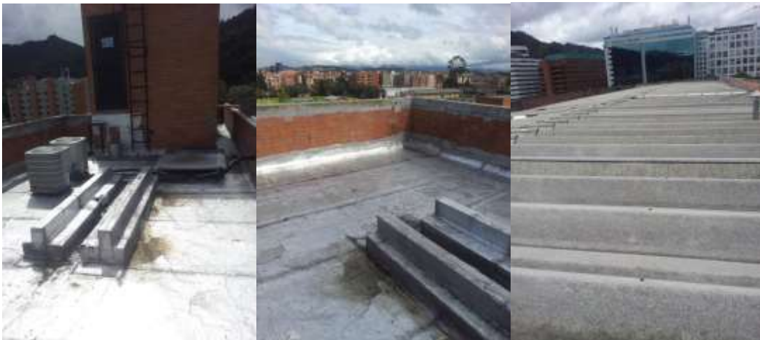
Ilustración 16 Techo edificio E
