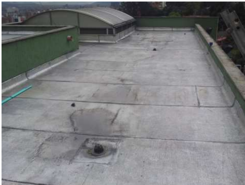
Ilustración 57 Cubierta - Edificio Germán Díaz Díaz
