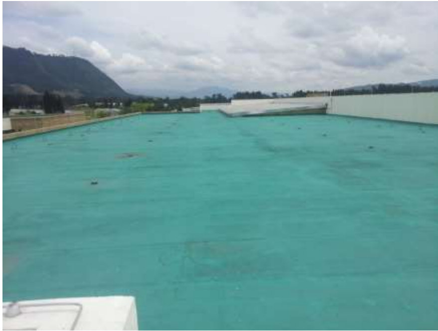
Ilustración 33 Techos: Edificio Camacho Leyva
