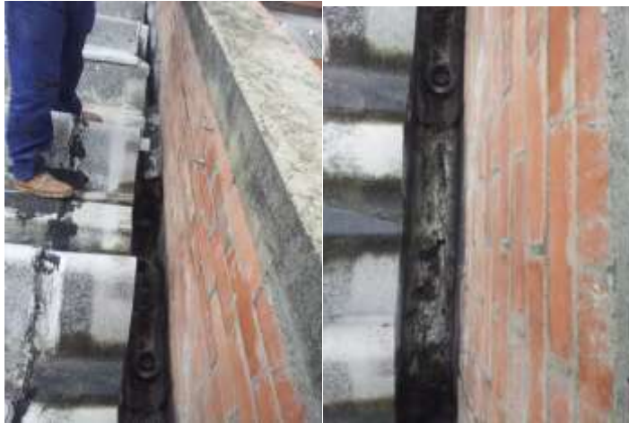
Ilustración 18 Viga-canales - Edificio E
