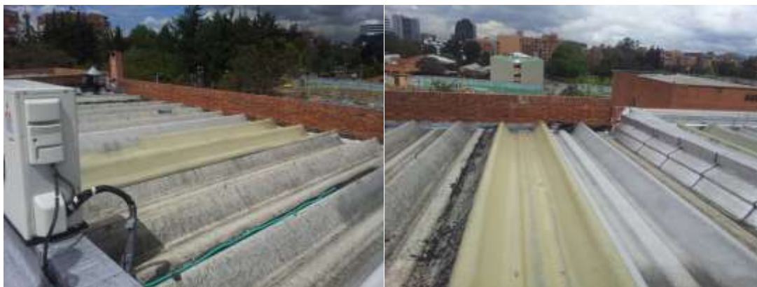
Ilustración 22 Mantenimiento y reforzamiento de las cubiertas.
