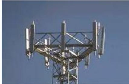
**Figura 1.** Antenas direccionales.
