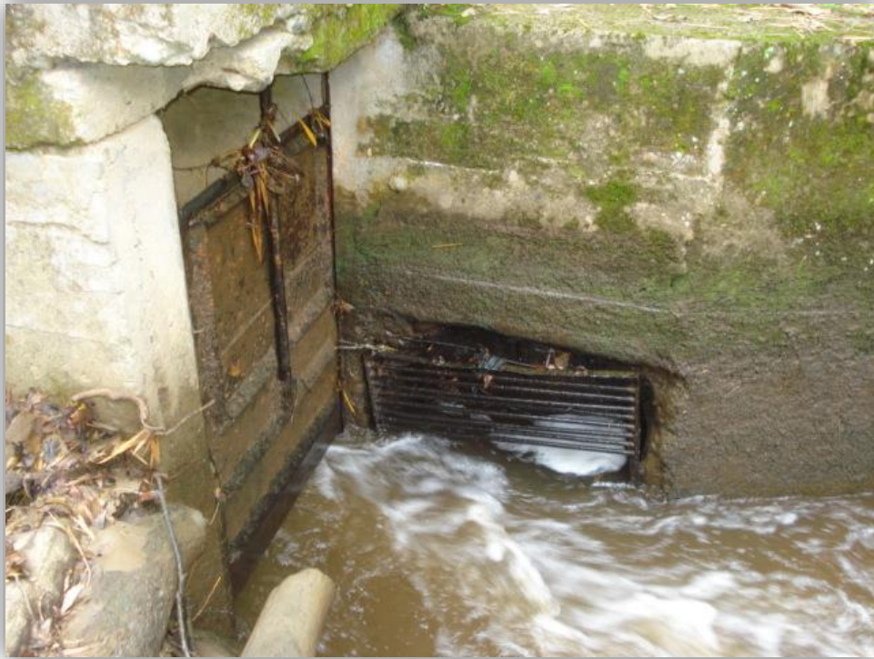
Foto 4: Cortina y rejilla lateral - Bocatoma Antigua
