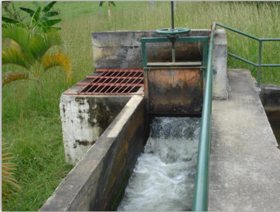
Foto 8: Entrada a la Planta - Canal de quietamiento
