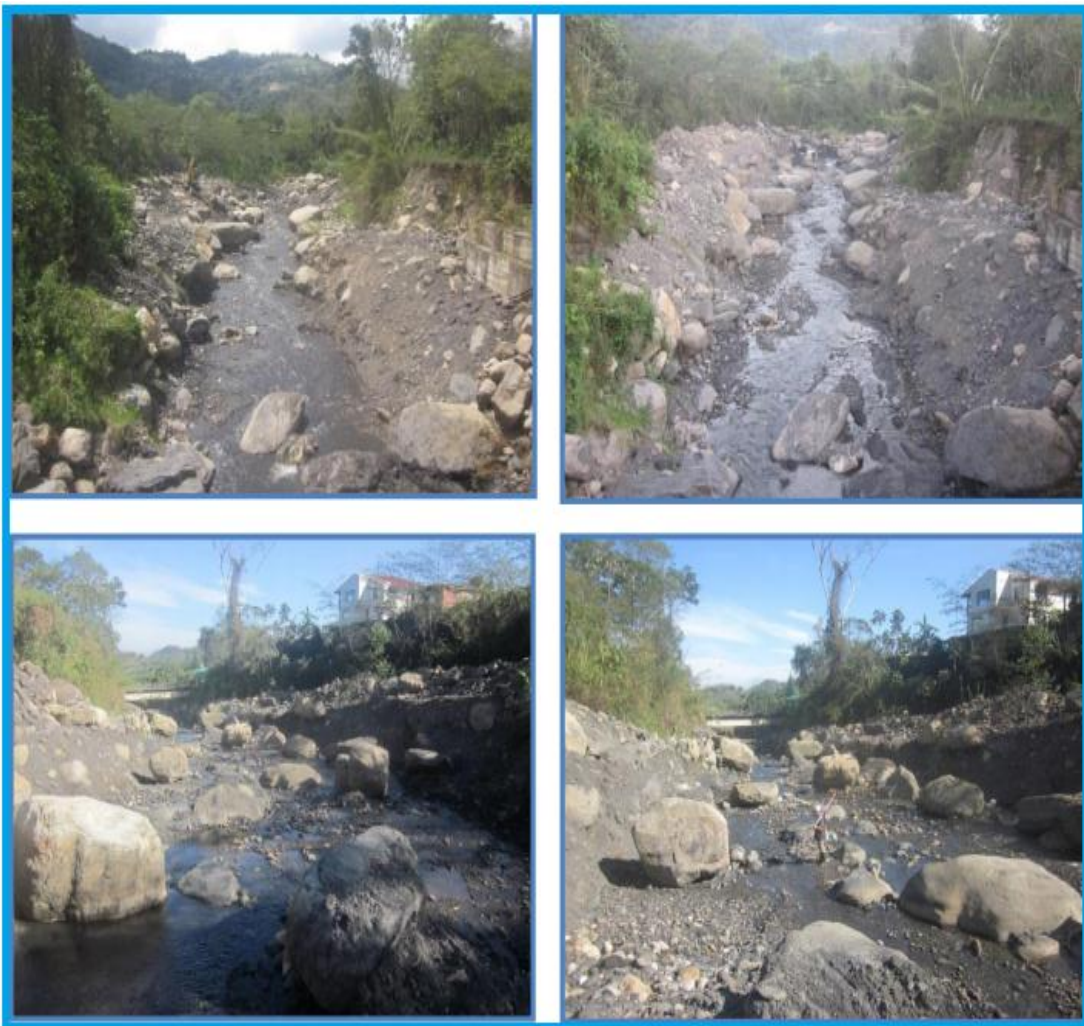
Figura 22. obras terminadas en el sector Hotel Don Juan
