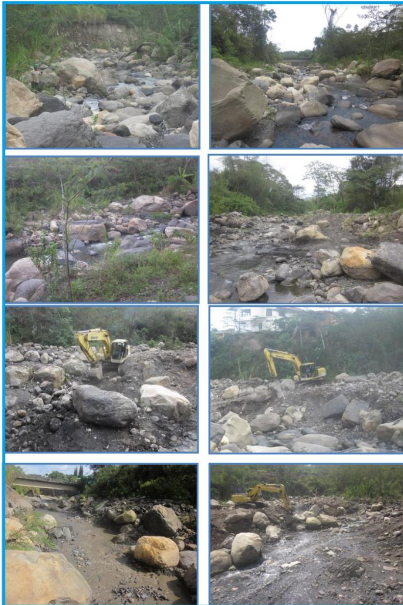
Figura 21. Labores de corte y movimiento de bolos sector Hotel Don Juan
