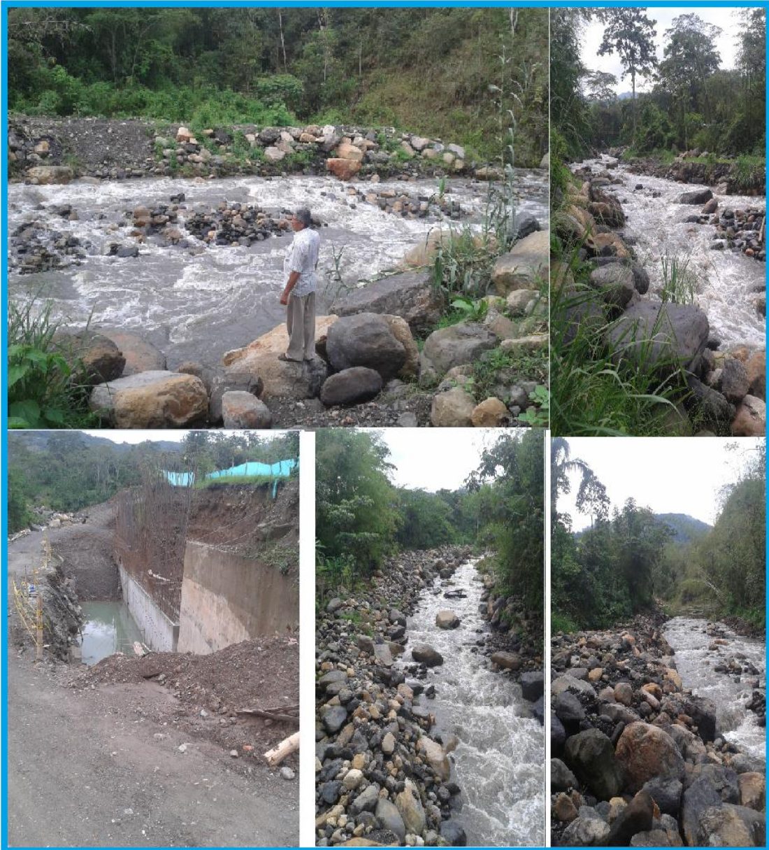
Figura 27. Acompañamiento a las obras con un ciudadano de La Vega
