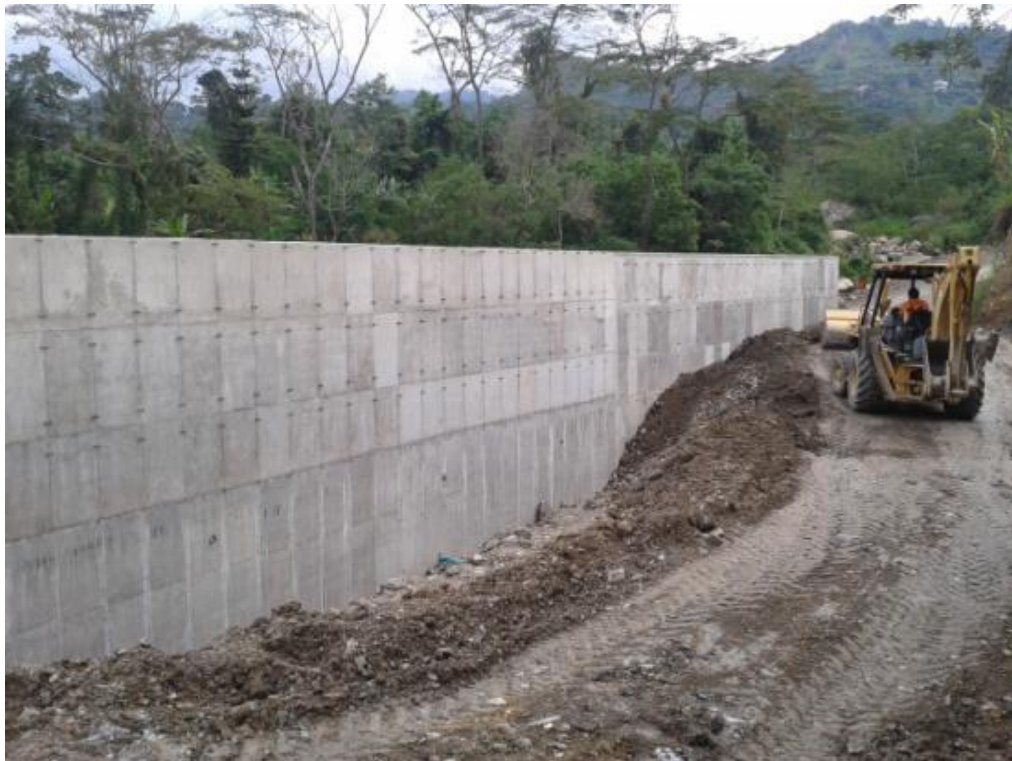
Figura 30. Culmina proceso constructivo del muro de contención en el sector Cural
