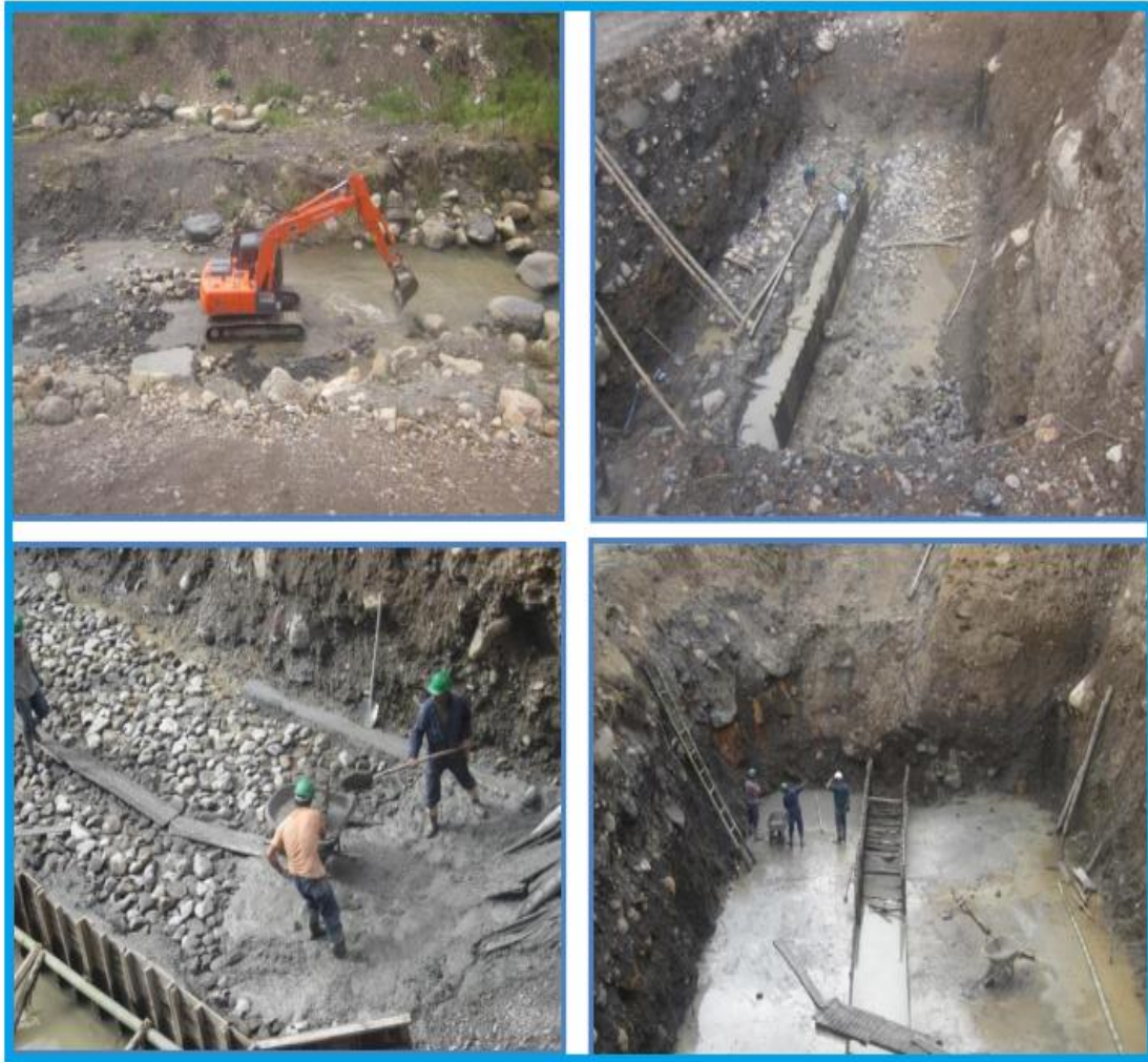
Figura 18. Fundición zarpa y conformación de jarillones
