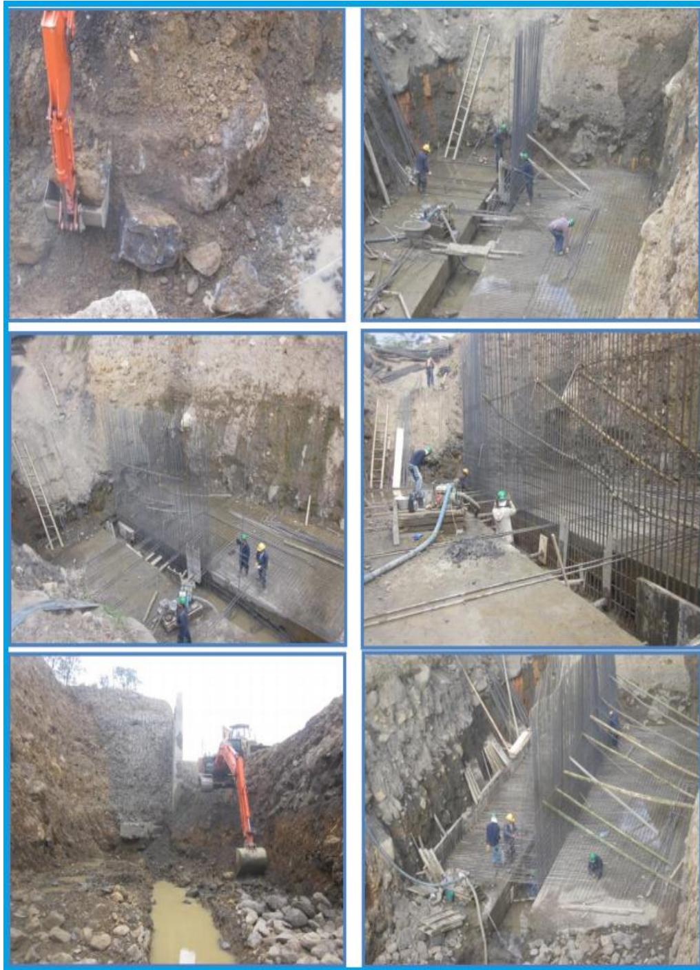
Figura 19. Trabajo de amarres para el dentellón y la zarpa del muro
