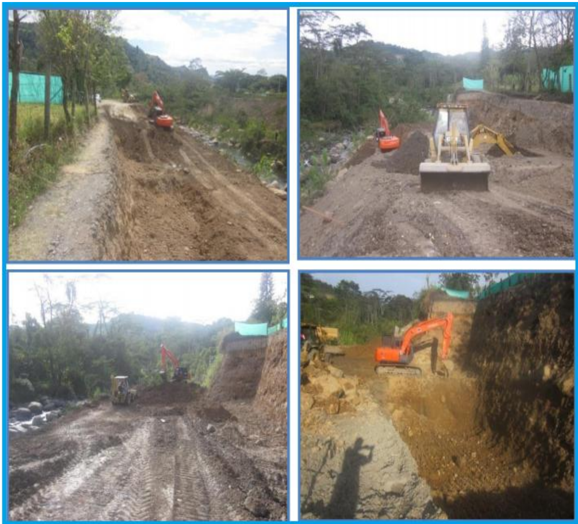
Figura 15. Excavación para el muro sector Cural
