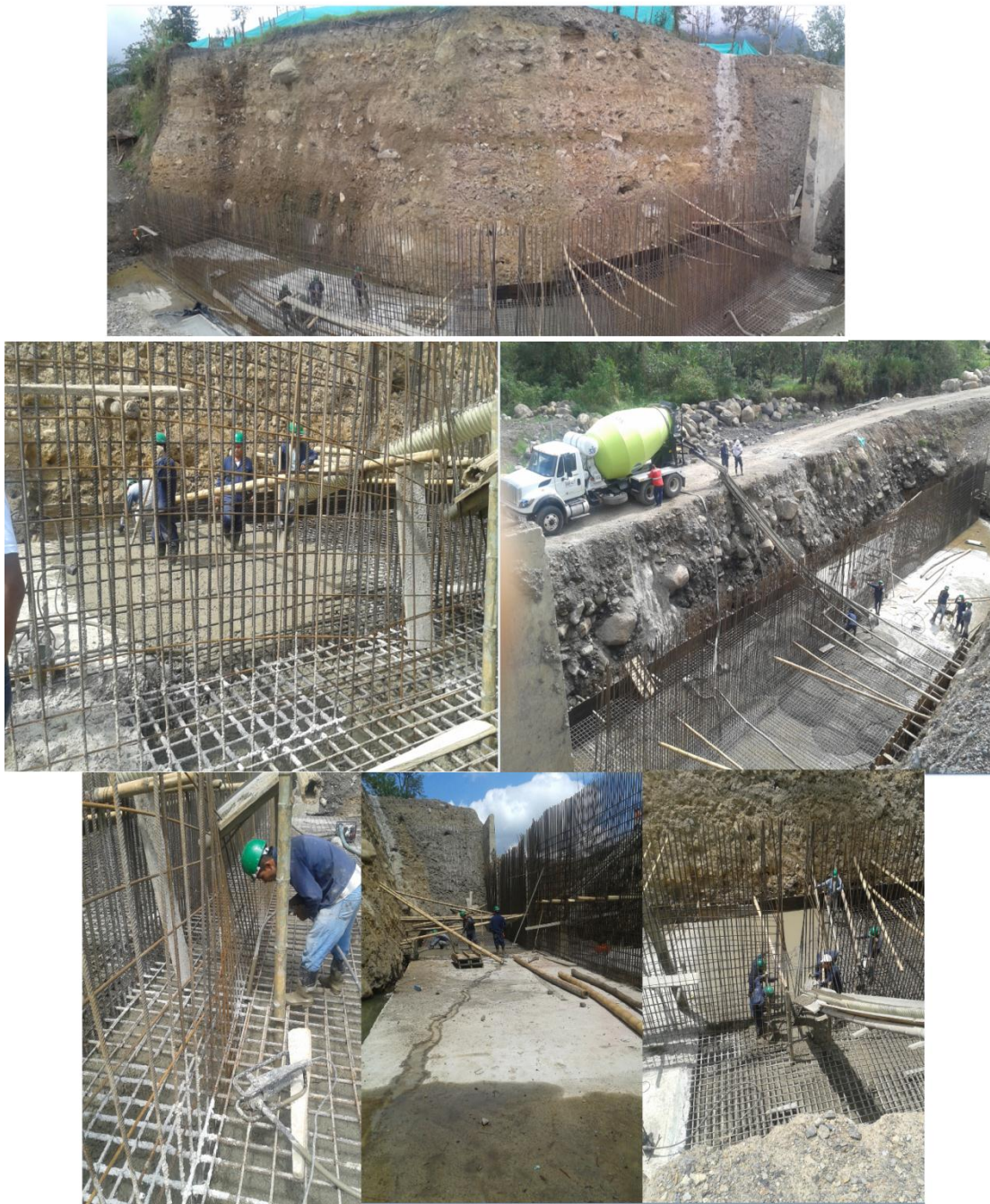
Figura 25. Fundición de la zarpa del muro de contención
