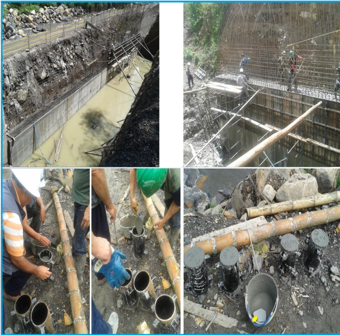
Figura 26. Cuerpo del muro y cilindros
