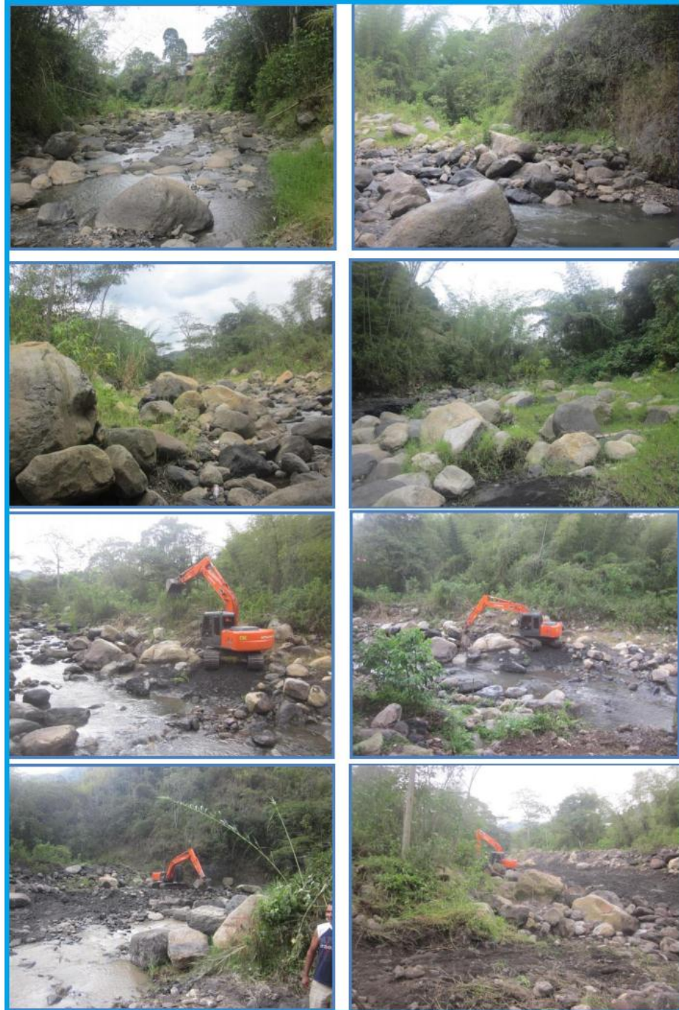
Figura 20. Sector Gaitán, antes, en el momento y después de realizar los jarillones
