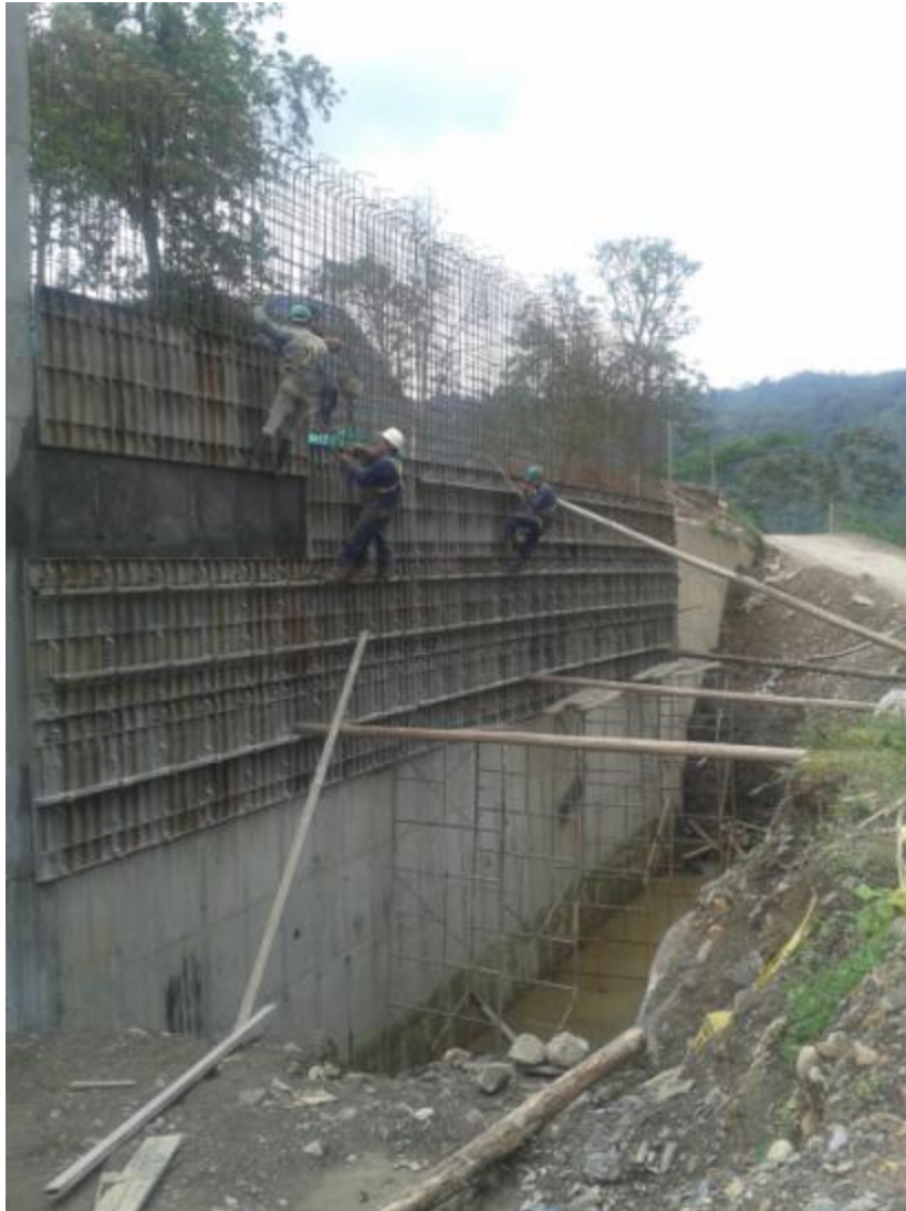
Figura 29. Proceso de desmonte y colocación de formaletas
