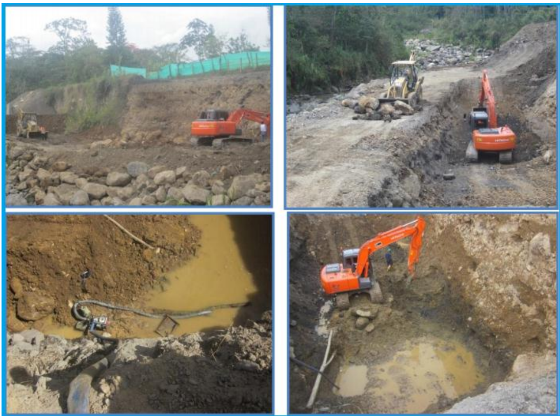
Figura 16. Conformación de Jarillón y excavación terminada
