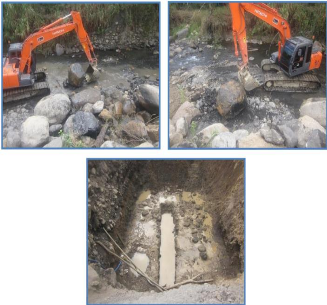
Figura 17. Excavación para el dentellón del muro y acomodamiento de bolos
