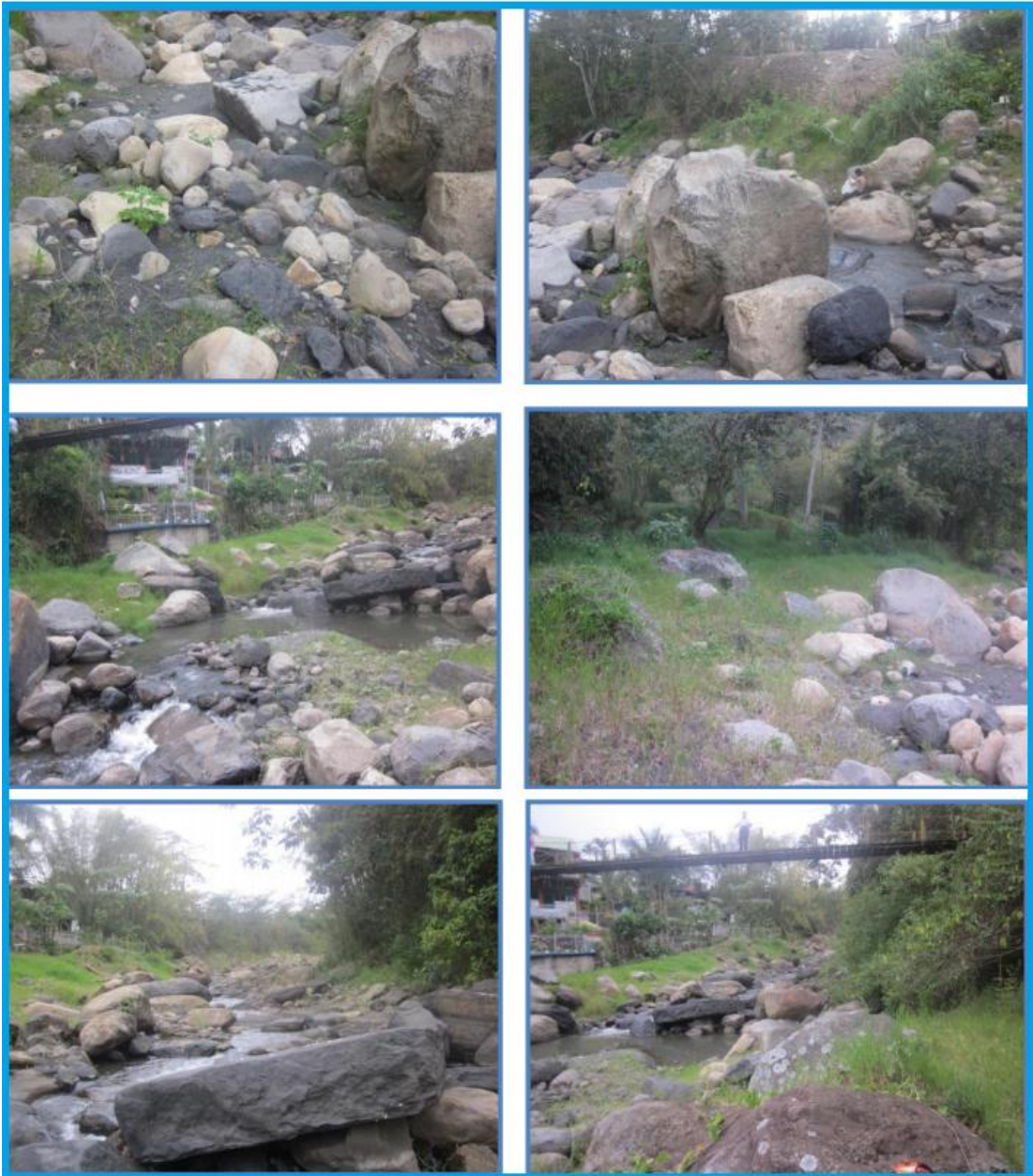
Figura 24. Sector Villa de Río labores de dragado y adecuación de bolos
