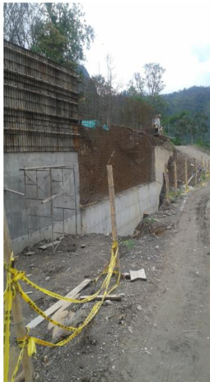
Figura 28. Muro de contención sector Cural.
