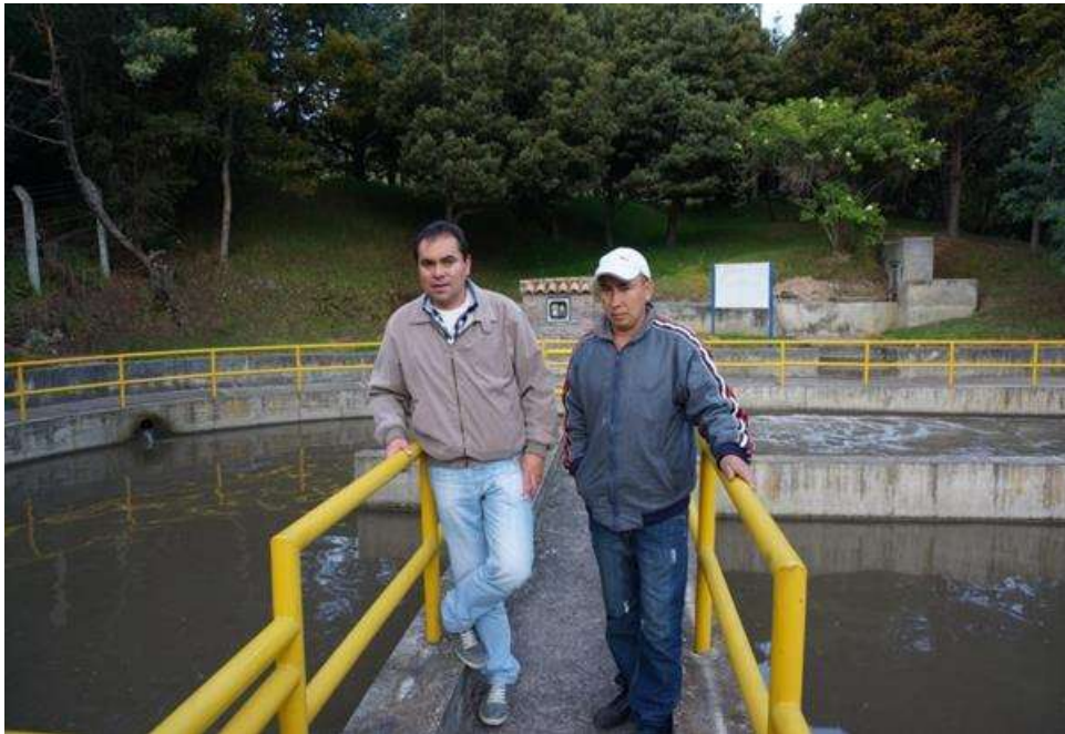
Figura 24. Zanja de oxidación PTAR Guatavita
