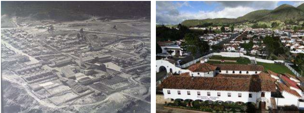
Figura 1. Vista Arquitectónica Guatavita 1967 y 2012
