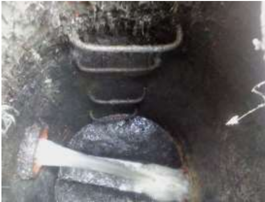
Figura 4. Pozo inspección alcantarillado
