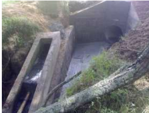
Figura 8. Estructuras de separación de aguas sector Montecillo Norte año 2013
