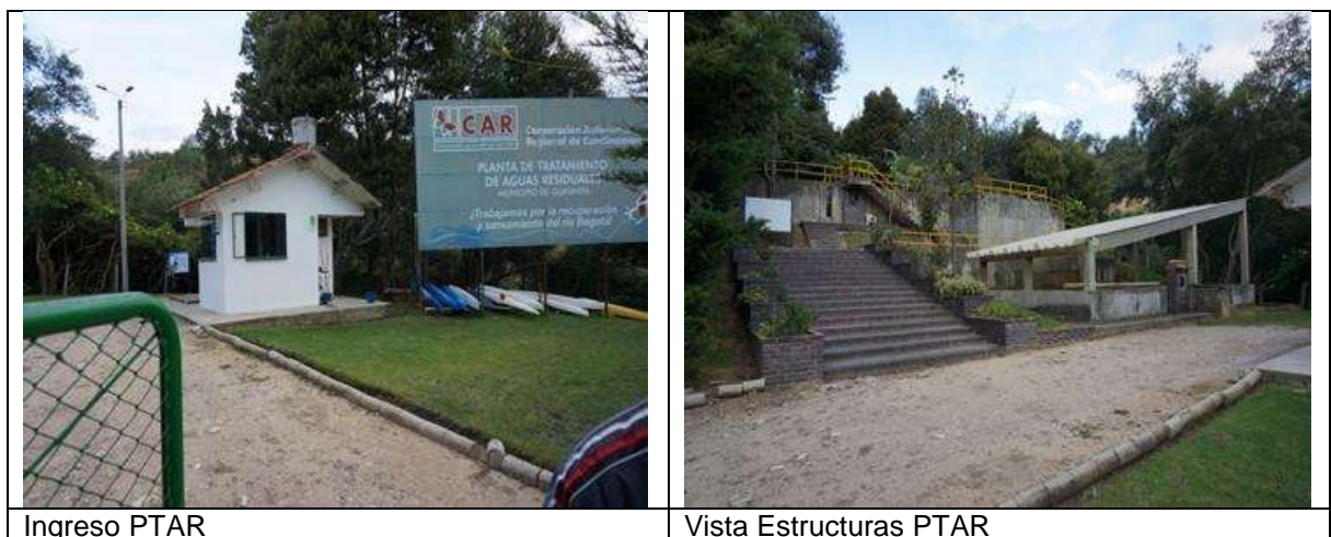
Figura 22. Vista PTAR Guatavita
