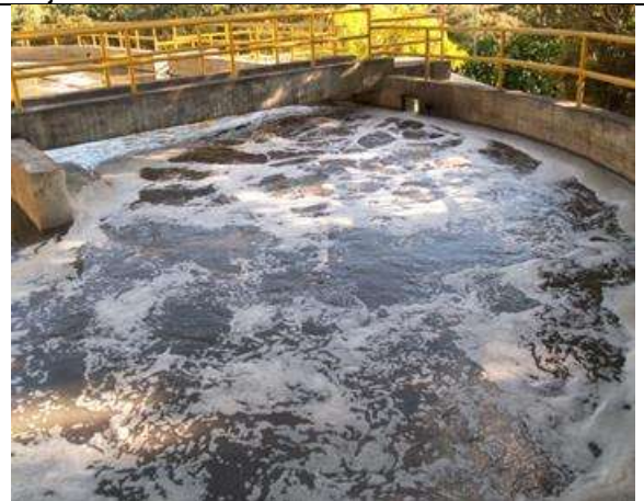
Zanjón de oxidación
