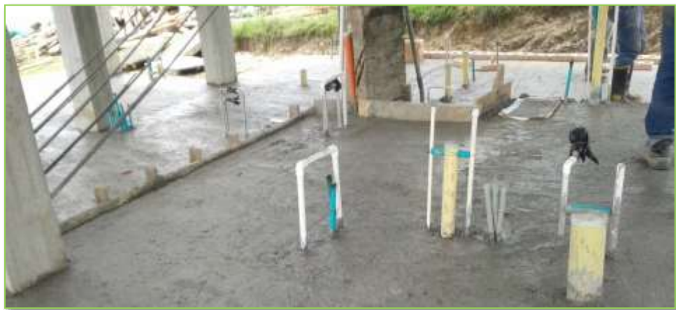
Figura 3. Prolongaciones de puntos hidráulicos en vivienda Etapa Ciruelos.
