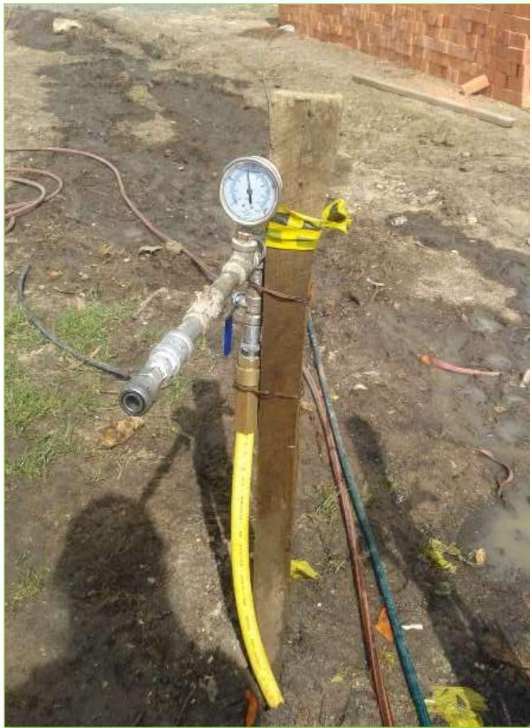
Figura 17. Prueba de presión Red principal suministro de gas
