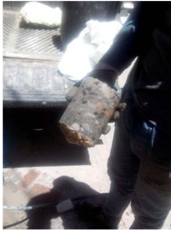
ILUSTRACIÓN 3: EXTRACCIÓN DE NÚCLEO 7 CALLE 3 SUR ENTRE CRA 3 Y 4
