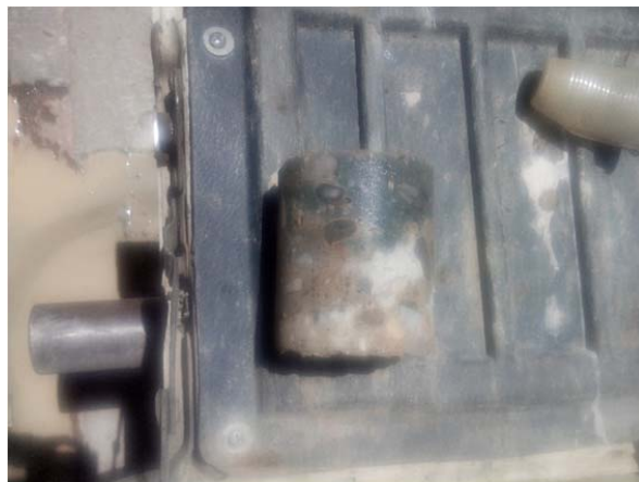
ILUSTRACIÓN 4: EXTRACCIÓN DE NÚCLEO 8 CALLE 3 SUR
