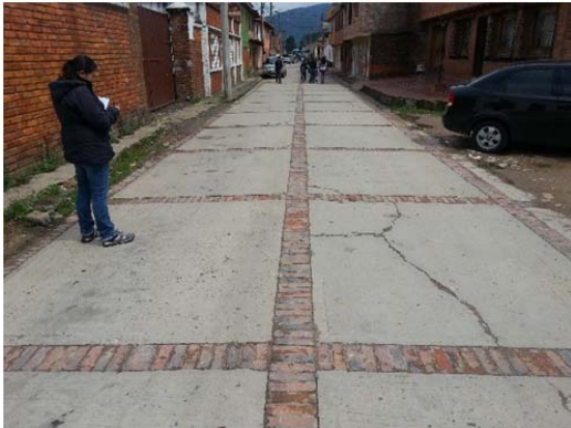
ILUSTRACIÓN 14: FISURAS LONGITUDINALES CALLE 4 ENTRE CRA 3 Y 4
