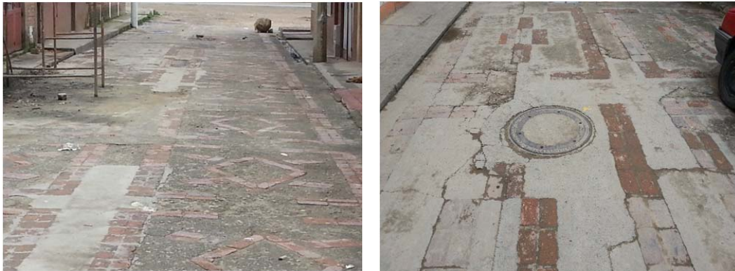
ILUSTRACIÓN 2: UBICACIÓN PLACAS ENTRE CALLE 3 SUR ENTRE CRA 3 Y 4
