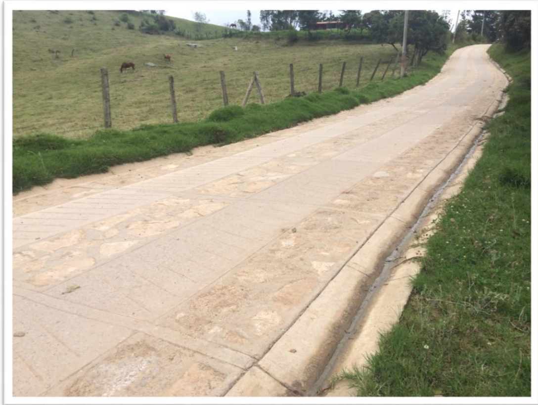
Figura 2. Foto del 15-11-2014, panorámica del pavimento en placa huella de la Vereda el Triunfo, Municipio de la Calera.
