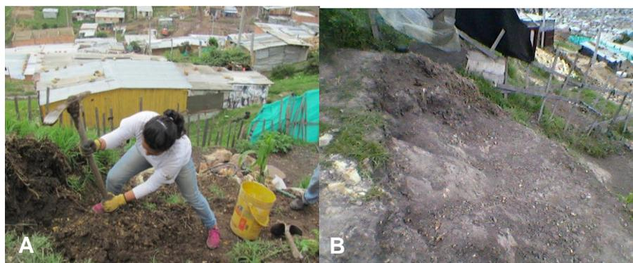
Figura 65. **A.** Arreglo de la pendiente del terreno **B.** Disminución de la pendiente del terreno
