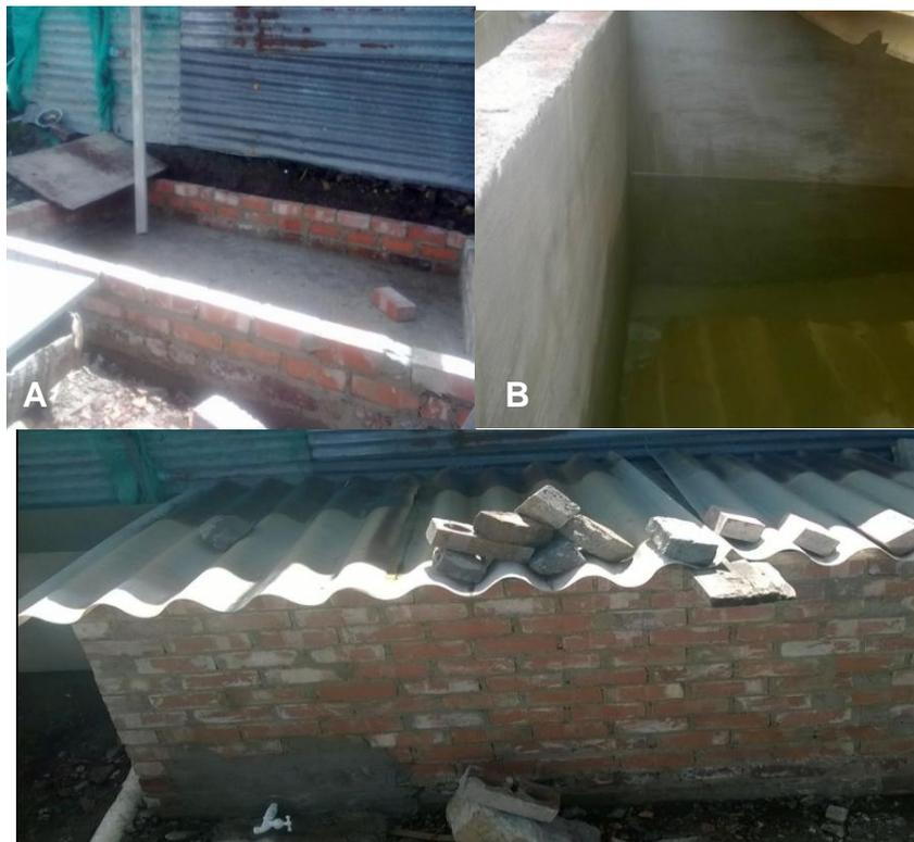
Figura 90 . **A.** Sobrecimiento del tanque. **B.** Impermeabilización y llenado del tanque **C.** Terminación del tanque de abastecimiento con sus respectivos aditamentos. Fuente: Hidalgo y Monroy, 2014
