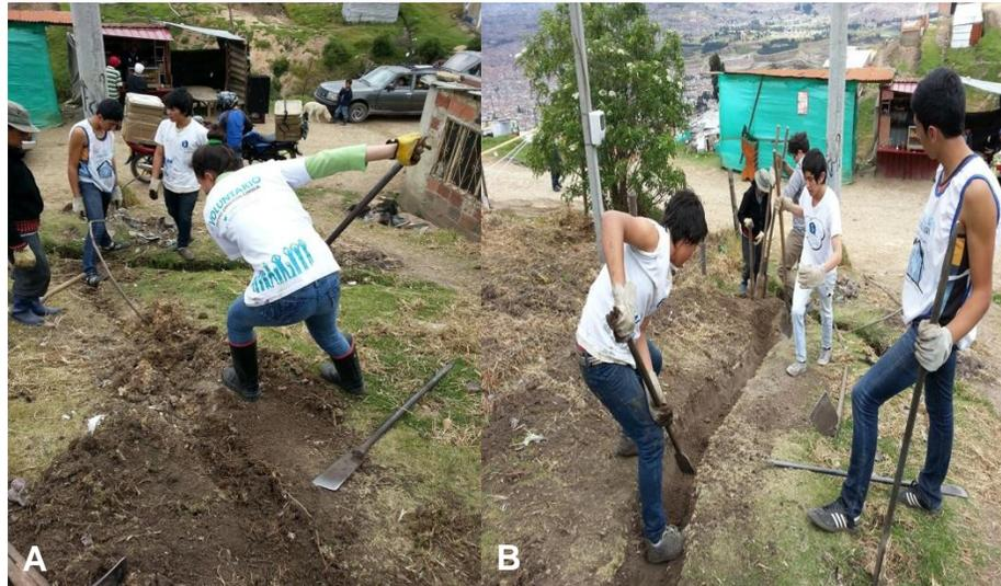
Figura 47. **A.** Excavación de la zanja y retiro de residuos **B.** Terminación de la zanja de aguas residuales.
