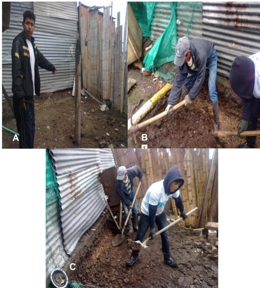
Figura 89. **A** Localización del terreno para el tanque de abastecimiento **B.** Punto de conexión aguas domésticas para el tanque **C.** Nivelación del terreno. Fuente: Pérez, 2014
