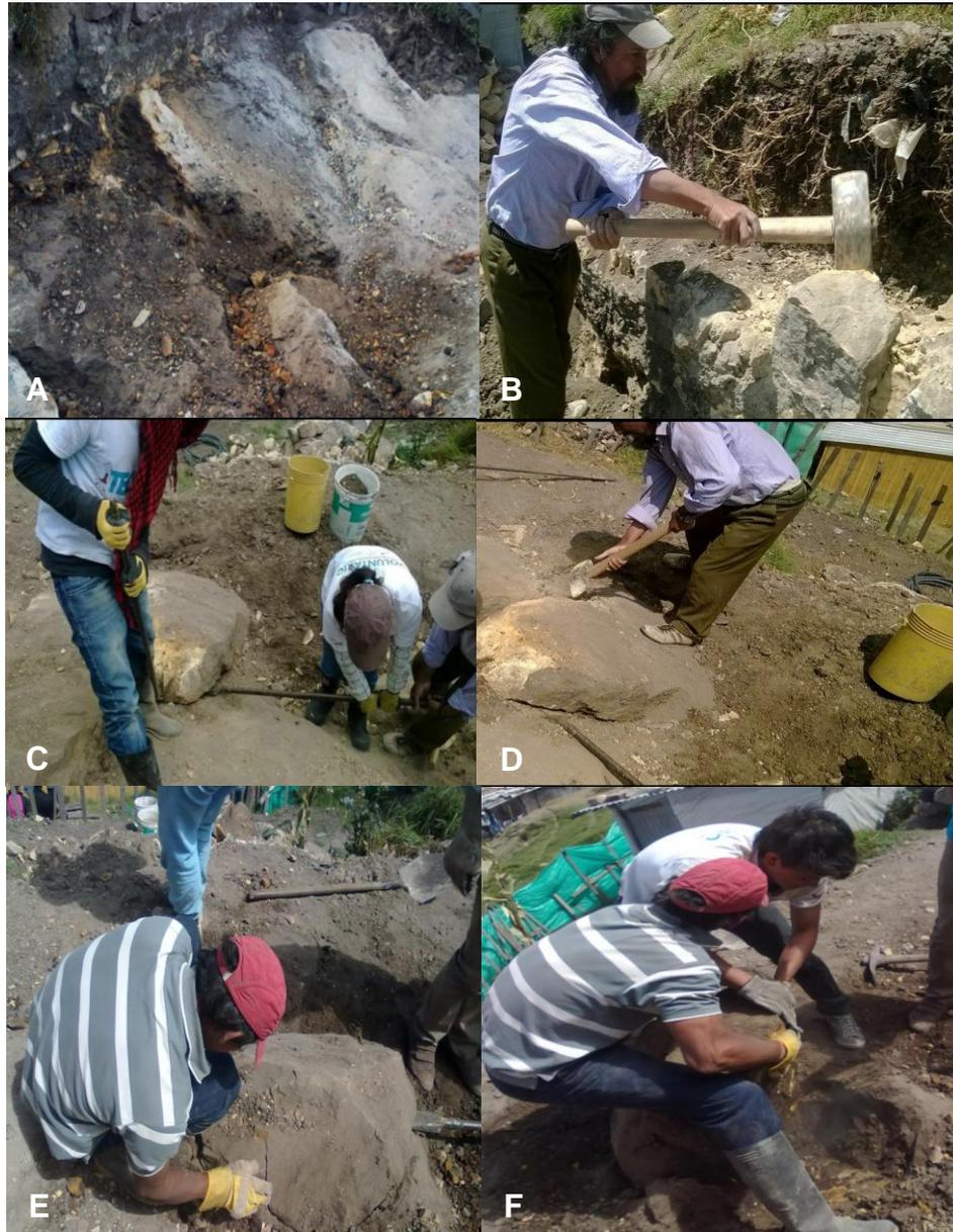
Figura 67. **A.** Areniscas intrusivas **B.** Extracción de la roca mediante mazo **C.** Palanca con barra en roca arenisca **D.** Golpes sucesivos para debilitar la roca **E.** Fractura en roca arenisca **F.** Extracción de roca arenisca.
