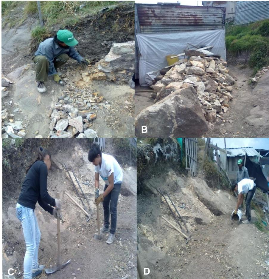
Figura 68. **A.** Remoción de roca arenisca **B.** Recopilación de roca arenisca **C.** Aplanado del terreno **D.** Terminación del terreno.
