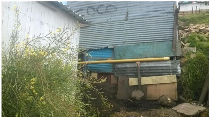
Figura 104. Conexión de tubo de aguas negras al alcantarillado
