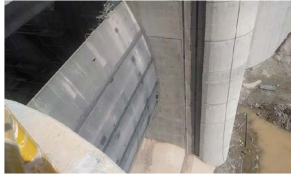
Figura 2 y 3: Vertedero Proyecto Hidroeléctrico el Quimbo en su fase de construcción con las respectivas compuertas.
