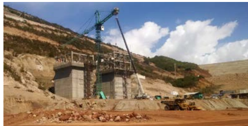
Figura 4: Estructuras de toma con rejillas del Proyecto Hidroeléctrico el Quimbo
