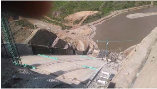
Figura 2 y 3: Vertedero Proyecto Hidroeléctrico el Quimbo en su fase de construcción con las respectivas compuertas.
