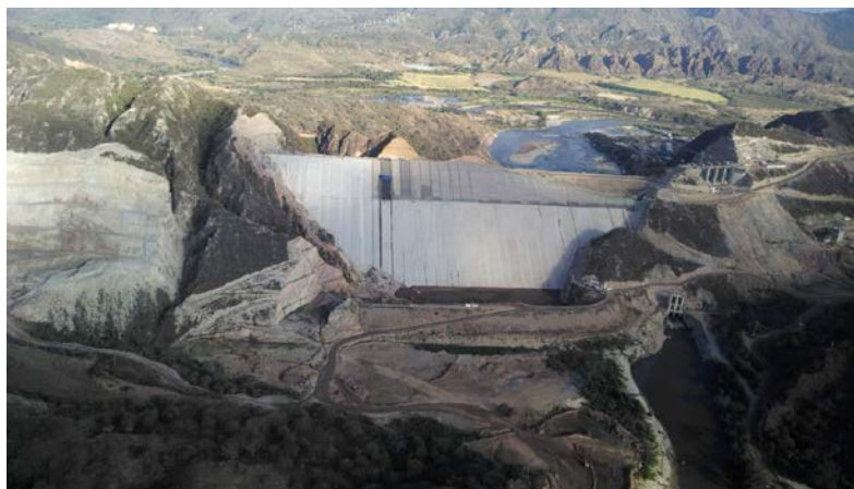
Figura 1: Presa CFRD. Proyecto Hidroeléctrico el Quimbo. Vuelo de reconocimiento.
