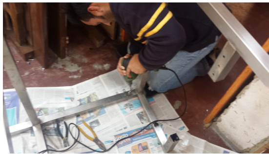
Figura 5.5: Adecuación de la Estructura de soporte
